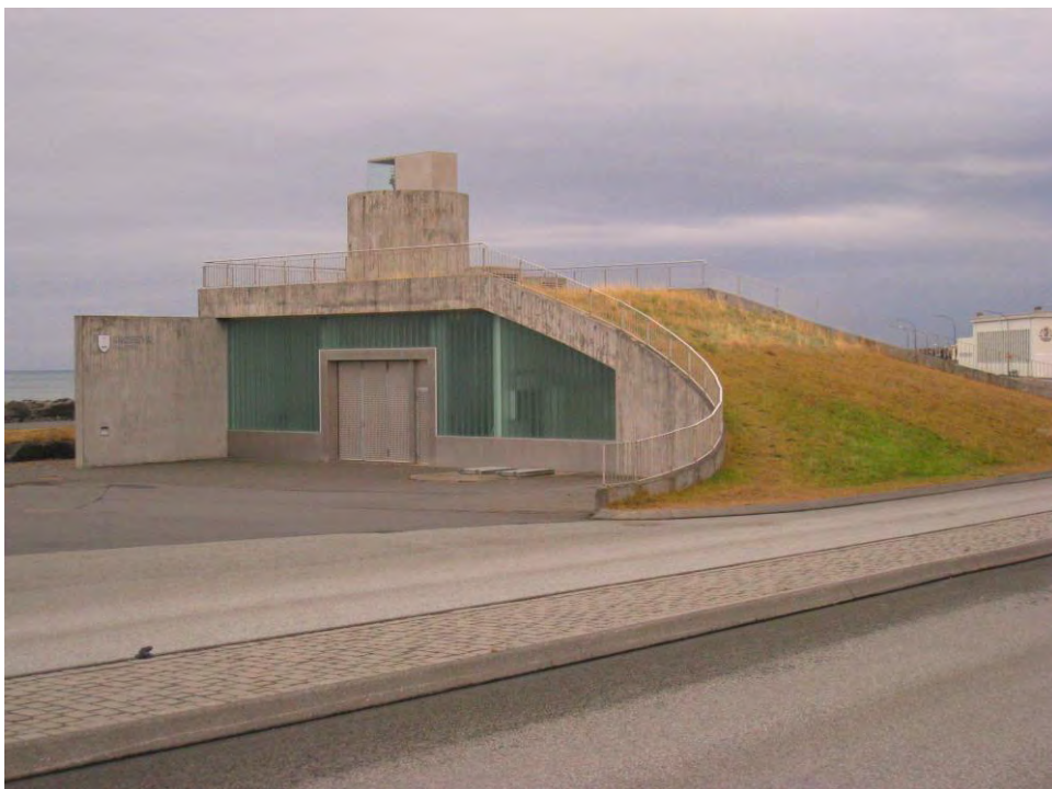
Nýleg dælustöð við Norðurgarð
