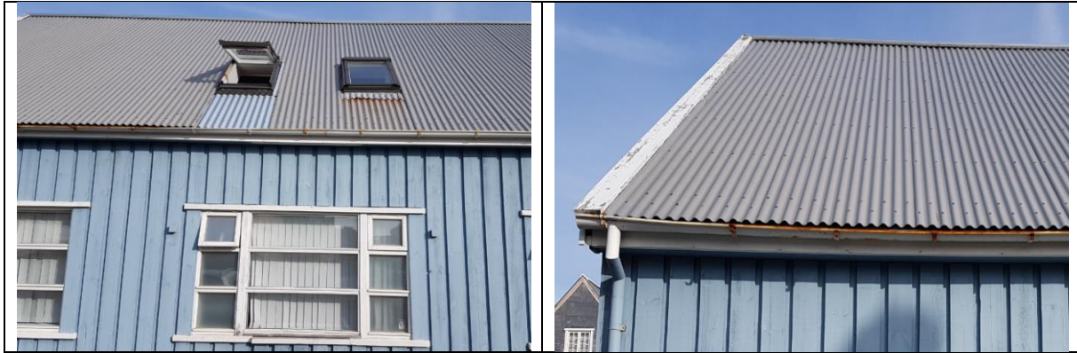
Myndir. Endurmála þarf þakjárn og lagfæra rennur.
