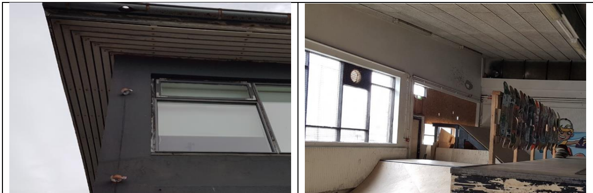
Mynd. Endurnýja þarf tréverk að hluta. Endurnýja þarf rennur og niðurföll. Endurmála þarf vegg og lakka gólf innanhúss.
