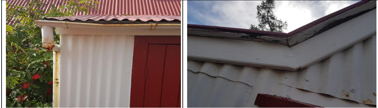
Mynd. Endurnýja þarf þakjárn, rennur og niðurföll.
