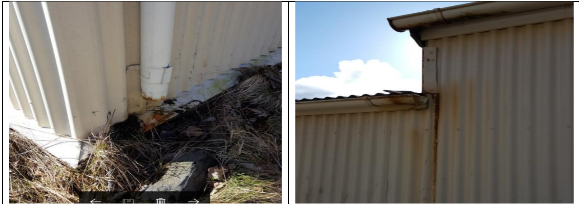
Mynd. Endurmála þarf bárujárnsklæðningu og laga rennur og niðurföll.
