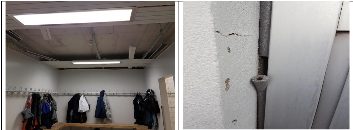
Mynd. Álstrímlaloft eru víða illa farin. Laga þarf þéttingar með gluggakerfum.
