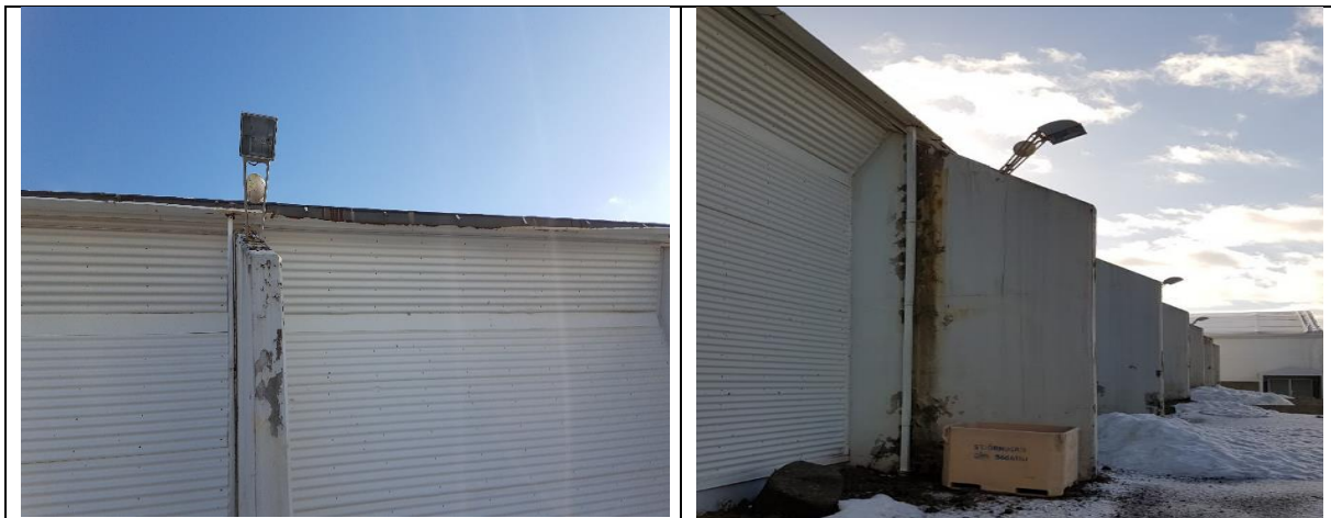
Mynd. Í B álmu þarf að endurnýja rennur og niðurföll, gera við steypa fleti og endurmála.
