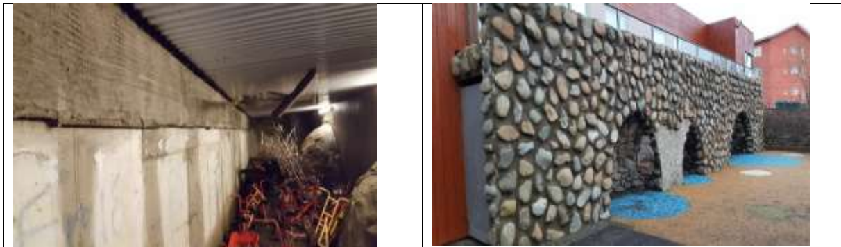
Mynd. Geymsla undir palli austanmegin er lek. Steinklæðning á geymslunni er hrúin af að hluta.
