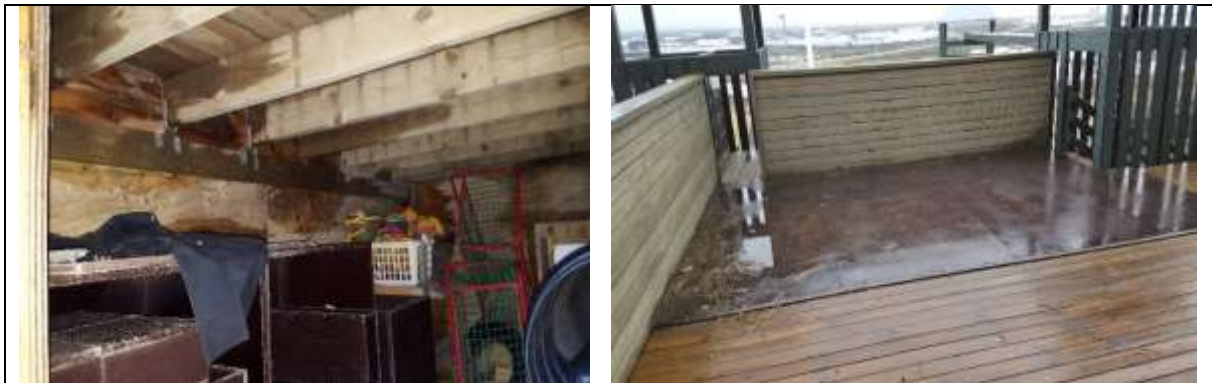
Mynd. Leikfangageymsla undir timburpalli er lek. Að hafa timburgólf sem þak yfir geymslu sem á að vera þurr, er ekki skynsamlegt.
