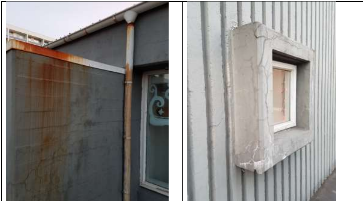
Mynd. Laga rennur og og járn. Löngu kominn tími á sprunguviðgerðir og málun á húsi
