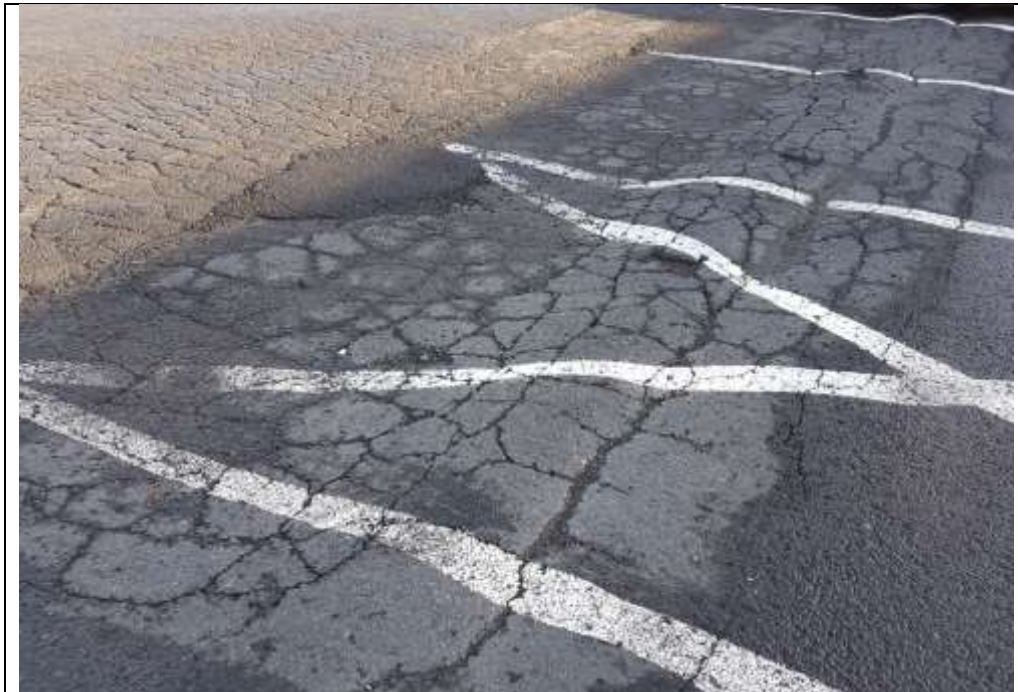
Mynd. Malbika þarf bílaplan og jarðvegsskipta vegna frostlyftingar.
