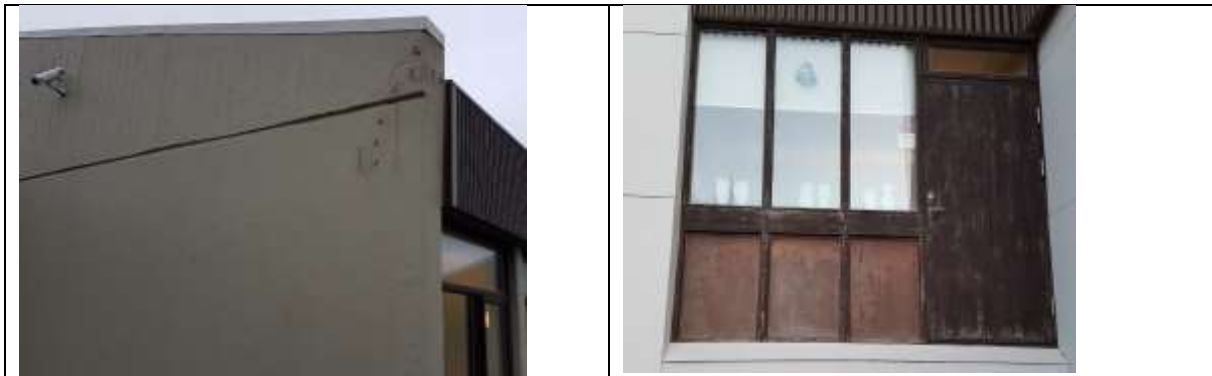
Mynd. Mála útvegg eftir sprunguviðgerðir. Bera á timburverk.
