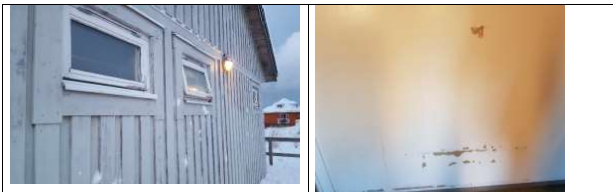
Mynd. Endurmála þarf þakjárn, skipta út festingum og flasningum. Endurmála þarf færanlegar kennslustofur. Veggi og glugga innandyra þarf að mála.
