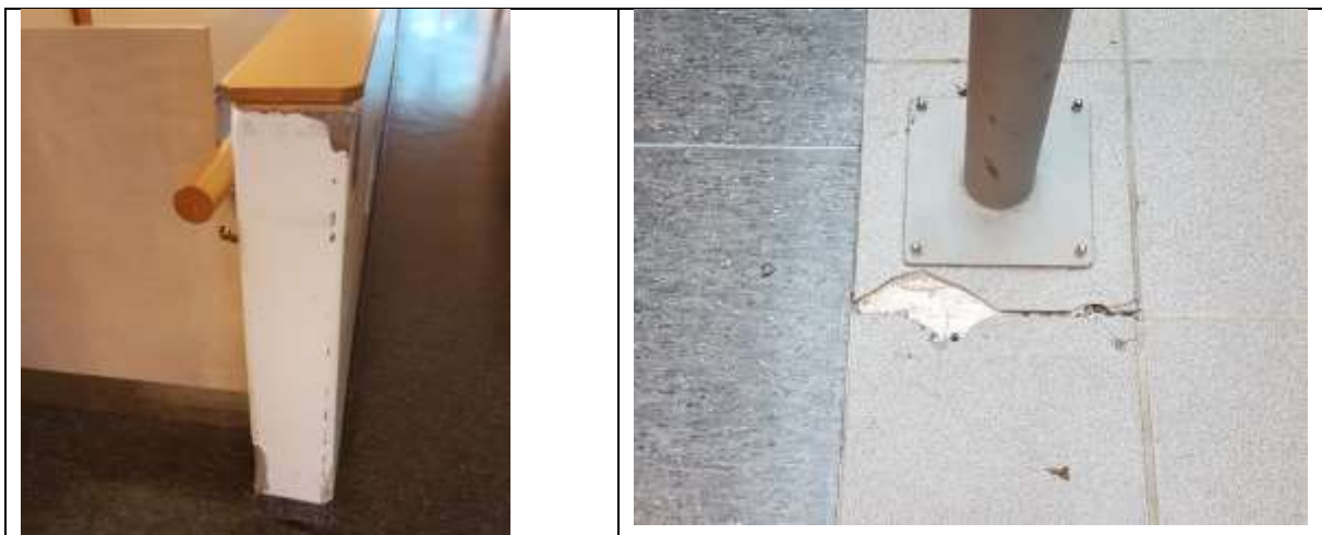
Mynd. Ýmsar smáviðgerðir innandyra s.s. brotið upp úr veggjum, laga gólfefni
