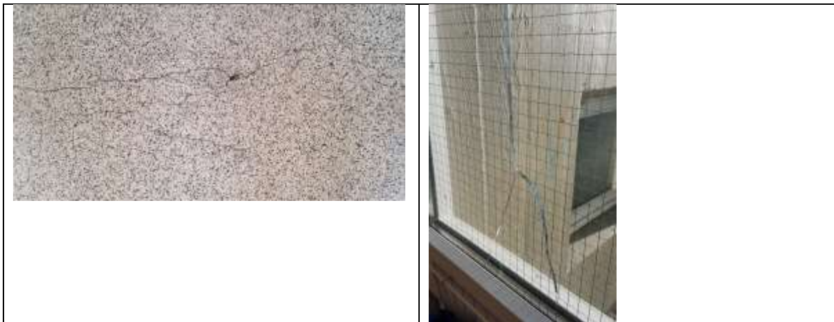
Mynd. Laga þarf sprungur í gólfefni. Skipta um brotið gler í glugga.
