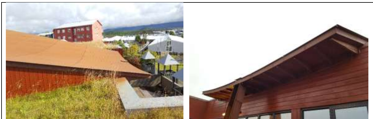
Mynd. Regnvatnsrenna annar ekki vatnsmagni frá þaki. Vatn sem skilar sér niður rennuna safnast fyrir á lóðinni og þar myndast tjörn sem er hættuleg fyrir börnin.
