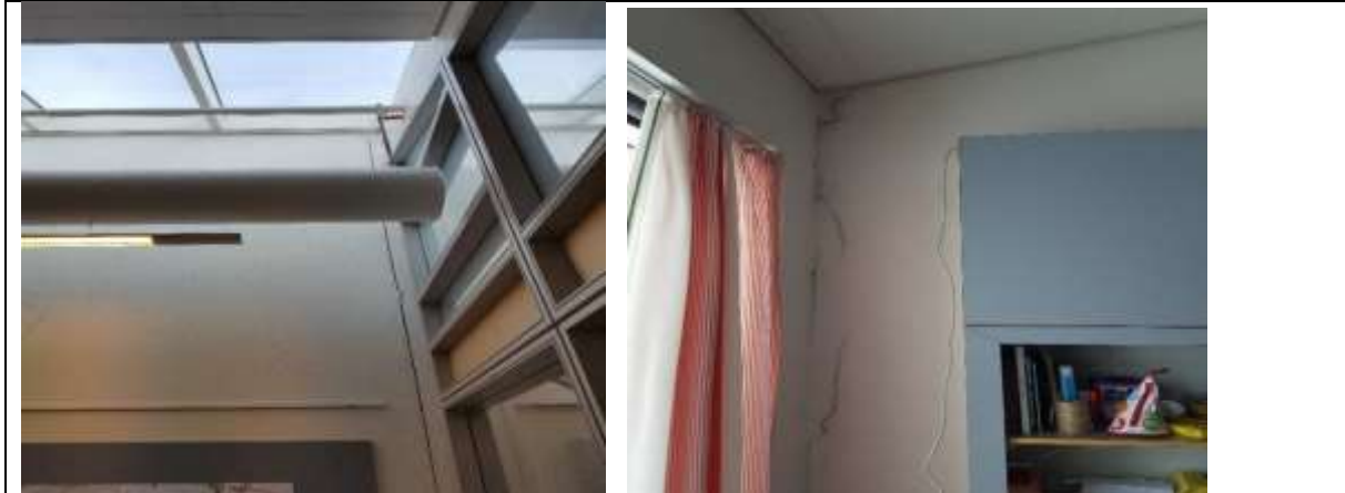
Mynd. Í vesturhluta byggingarinnar er töluvert um sprungur í veggjum.
