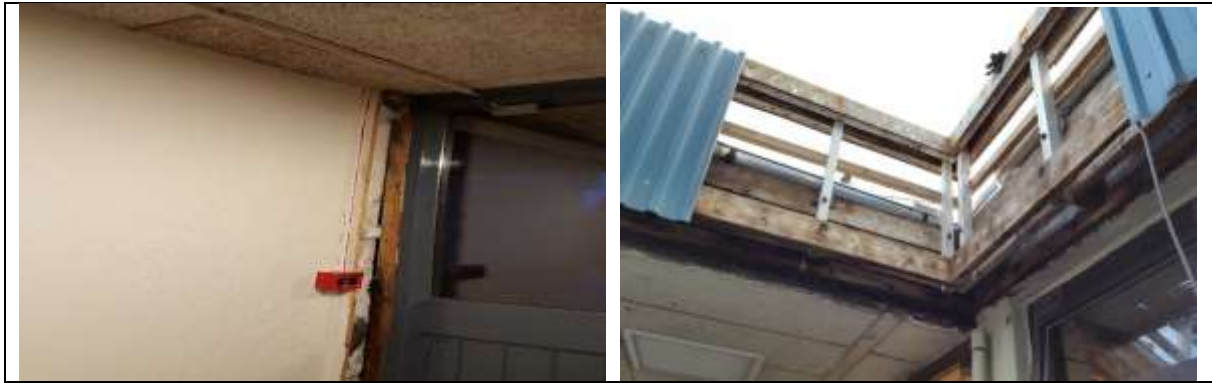
Mynd. Í tengibyggingu milli D og E álmu var mikill leki sem skilaði sér inn í bygginguna laga þarf skemmdir innanhús vegna leka.
