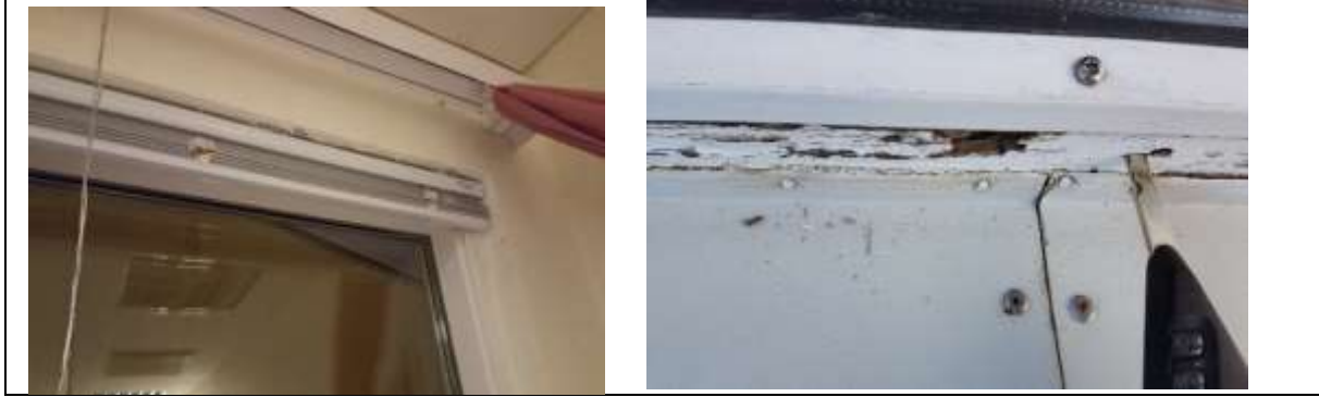
Mynd. Í í C álmu eru komnar rakaskemmdir innanhúss í skrifstofuherbergi og kennarastofu. B álmu eru kominn fúi í nokkra glugga
