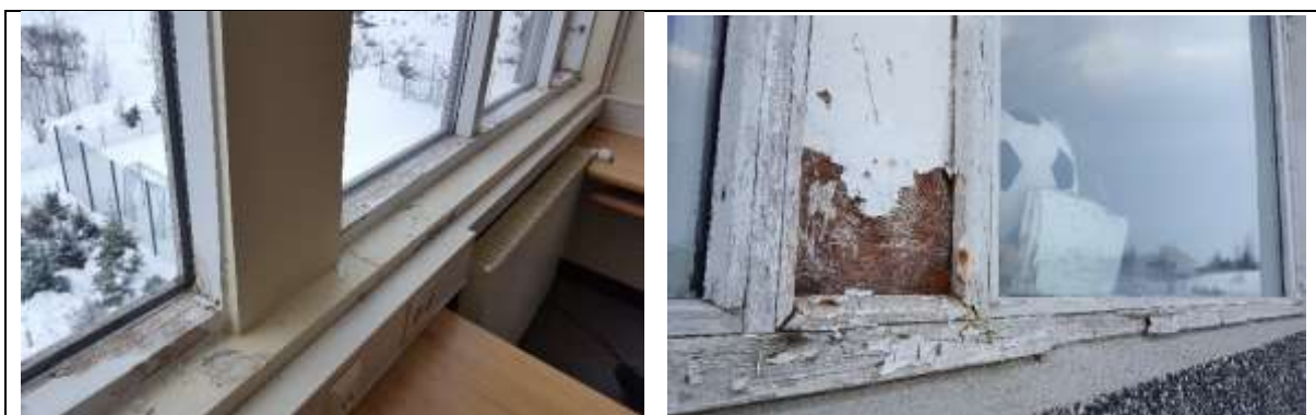
Mynd. Í A álmu eru komnar miklar rakaskemmdir í kennslustofur á suðurgafli. Gluggarnir eru ónýtir.
