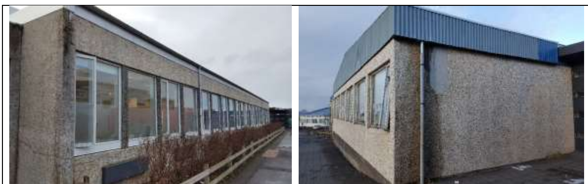
Mynd. Í B og D álmu er steiningin orðin töluvert sprungin og farin af á nokkrum stöðum.
