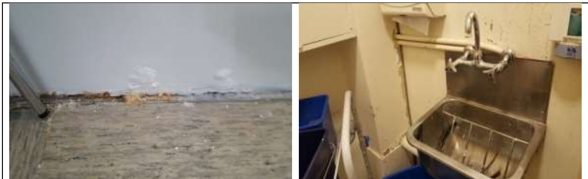
Mynd. Í B álmu verður farið í að koma í veg fyrir raka sem skilar sér inn í gamla framköllunarherbergi í kjallara. Í geymslum eru veggir illa farnir og kominn tími á endurbætur.
