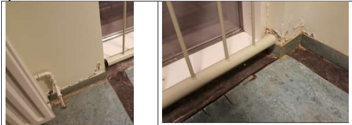
Mynd. Laga þarf rakaskemmdir á veggjum og dúk í setustofu.
