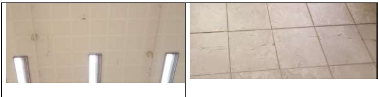
Mynd. Í íþróttasal þarf að skipta út loftaplötum og í andyri þarf að laga gólfplísar.
