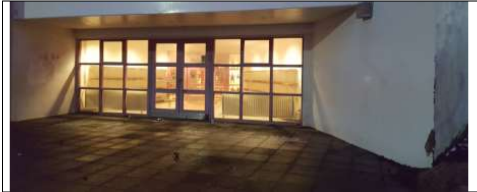
Mynd. Útihurðar orðnar lélegar og kominn tími á sprunguviðgerðir og málun utanhúss
