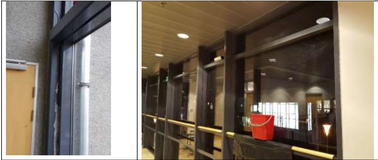
Mynd. Laga þarf rakavandamál þar sem lekur inn á nokkrum stöðum.
