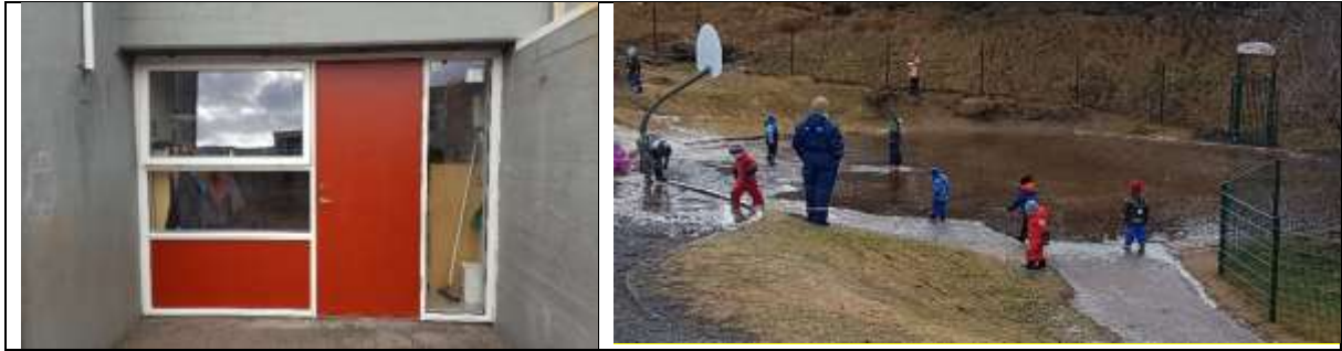
Mynd. Laga hæðarmismun við nýjar útihurðir. Laga leikskólalóð.
