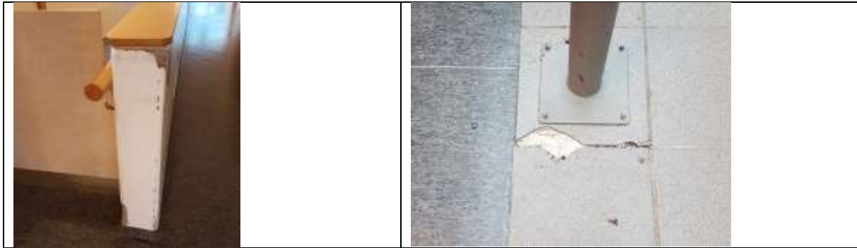
Mynd. Ýmsar smáviðgerðir innandyra s.s. brotið upp úr veggjum, laga gólfefni
