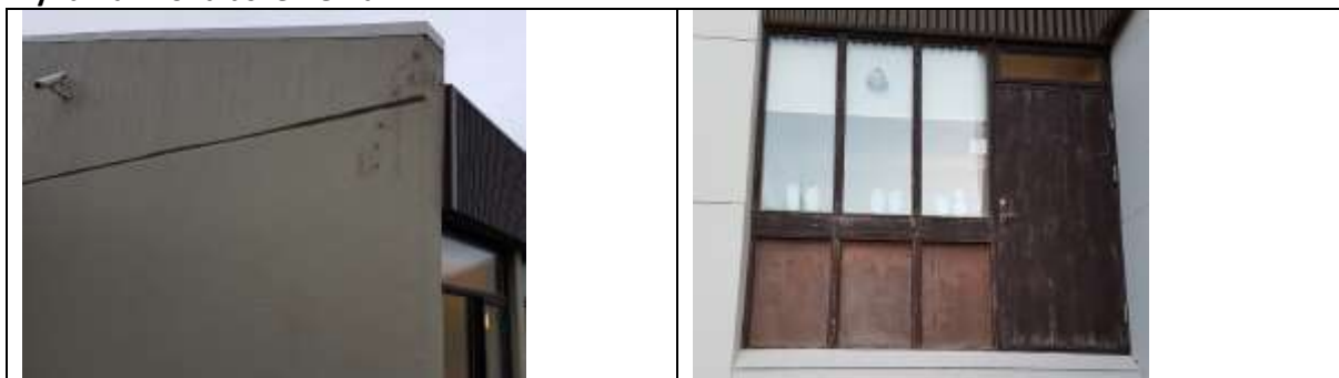
Mynd. Mála útvegg eftir sprunguviðgerðir. Bera á timburverk.
