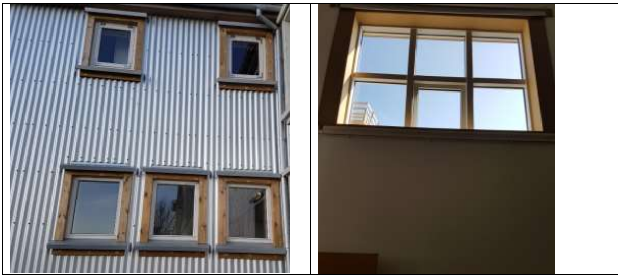
Mynd. Mála tréverk hringum glugga að tunaverðu. Setja lengingu á opnanleg fög í sal
