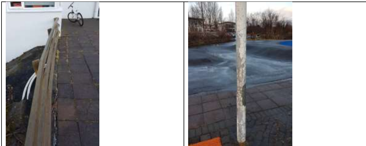
Mynd. Laga snjóbræðslu, hellulögn og mála ljósastaura
