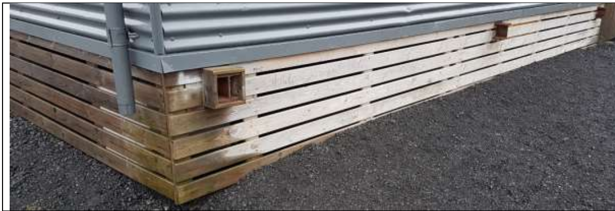
Mynd. Bera þarf á tréverk á færanlegu stofunum
