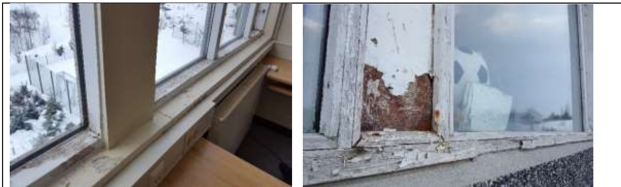
Mynd. Í A álmu eru komnar miklar rakaskemmdir í kennslustofur á suðurgafli. Gluggar eru ónýtir.
