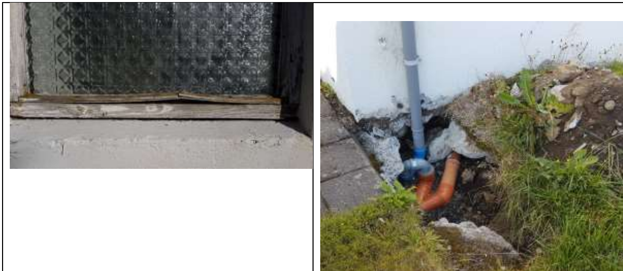
Mynd. Skipta þarf um nær alla glugga í smíðastofu. Ganga þarf frá lóð smíðastofum.a. vegna nýrra frárennslislagna og að olíutankur var fjarlægður á árinu 2019.
