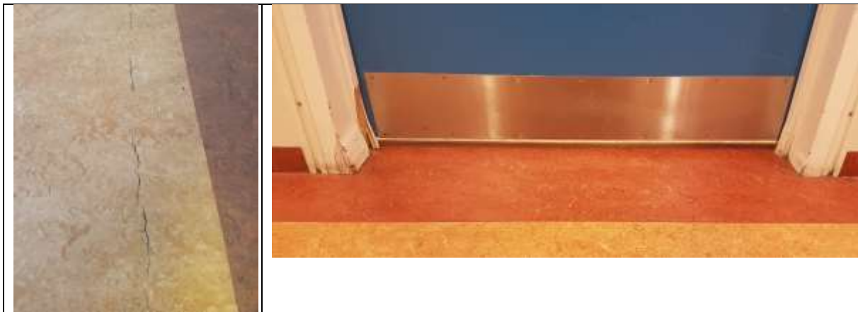
Mynd. Laga þarf gólfefni s.s. yfirfara suður og laga sprungur í dúkum. Hurðakarmar víða orðnir uppbólgnir vegna raka frá ræstingu.
