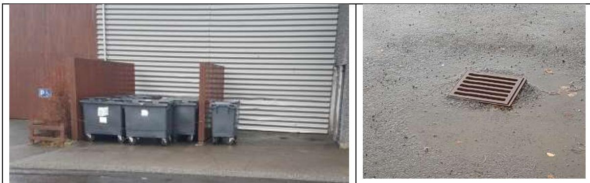
Mynd. Vantar ruslagerði. Niðurföll standa víða upp úr malbiki.
