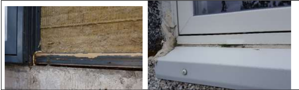
Mynd. Skipta þarf um skrúfur í öllum átrégluggum í skólanum þar sem skrúfur eru að hverfa vegna ryðs. Í Á álmu er leki við lyftuhús.
