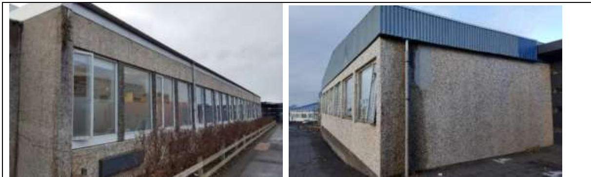
Mynd. Í D álmu er steiningin orðin töluvert sprungin á nokkrum stöðum.
