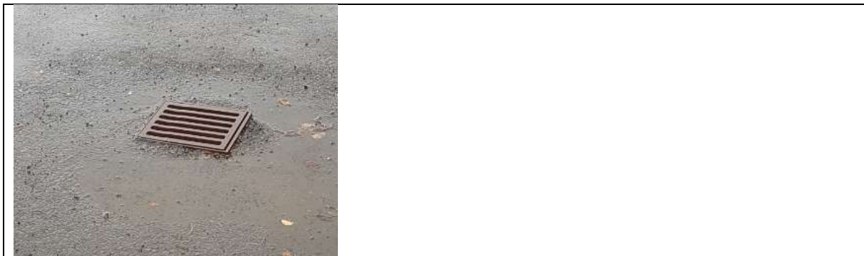
Mynd. Vantar ruslagerði. Niðurföll standa víða upp úr malbiki.
