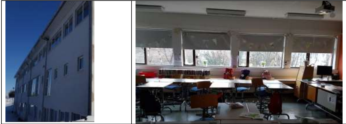
Mynd. Múrviðgerðir og málun á NV hlið skólans. Skipta þarf út nokkrum gluggum
