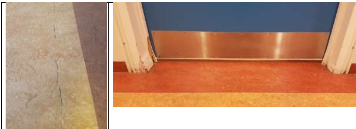
Mynd. Laga þarf gólfefni s.s. yfirfara suður og laga sprungur í dúkum. Hurðakarmar víða orðnir uppþógnir vegna raka frá ræstingu.
