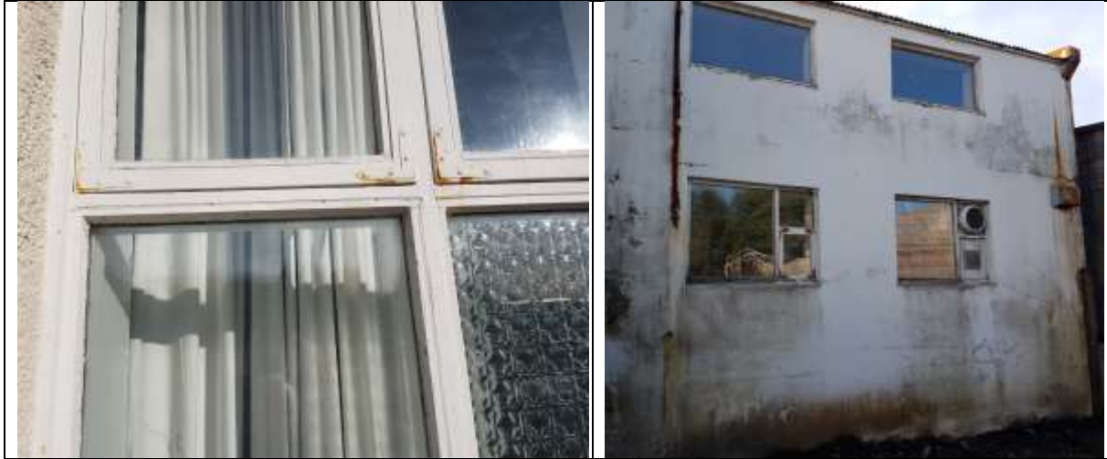
Mynd. Rið er í járn og skrúfum í gluggum Menntasetursins. Endurnýja þarf rennur á Smíðastofu, laga sprunguviðgerðir og mála eða klæða húsið
