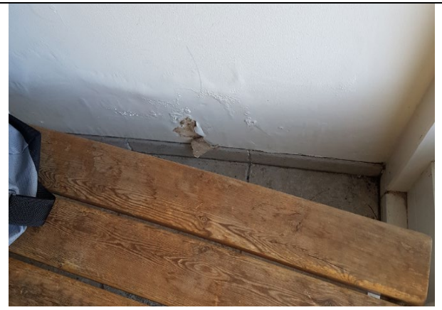
Mynd. Endurnýja þarf eldhúsinnréttingu. Koma þarf í veg fyrir rakaskemmdir í forstofu og gangi.
