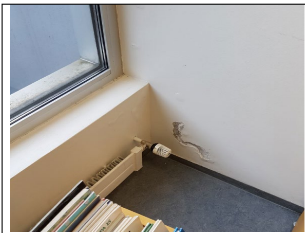
Myndir. Þarf að endurmála eftir rakaskemmdir.
