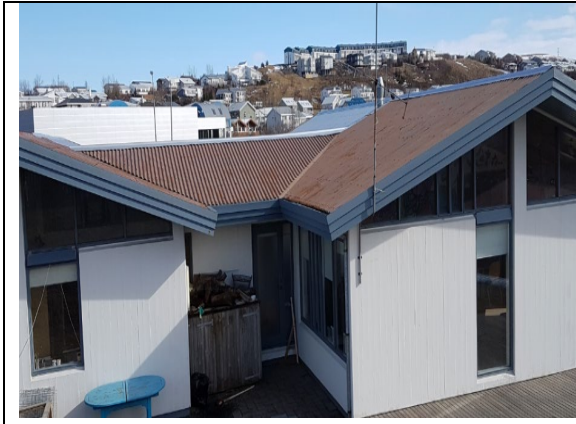
Mynd.. Endurnýja þarf þakjárn. Lagfæra þarf hellur og aðlaga lóð við bæjarland.
