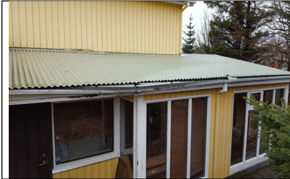
Mynd. Þakjárn þarf að yfirfara sem og rennur. Kominn er tími á að endurnýja eldhúsinnréttingu.
