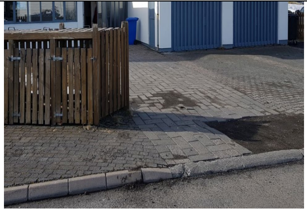
Mynd.. Endurnýja þarf þakjárn. Lagfæra þarf hellur og aðlaga lóð við bæjarland.
