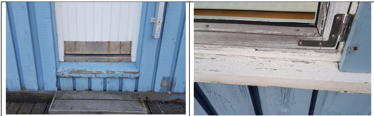
Myndir. Endurmála þarf allt tréverk utanhúss.
