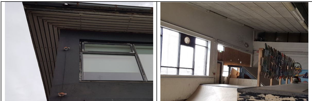
Mynd. Endurnýja þarf tréverk að hluta. Endurnýja þarf rennur og niðurföll. Endurmála þarf vegg og lakka gólf innanhúss.
