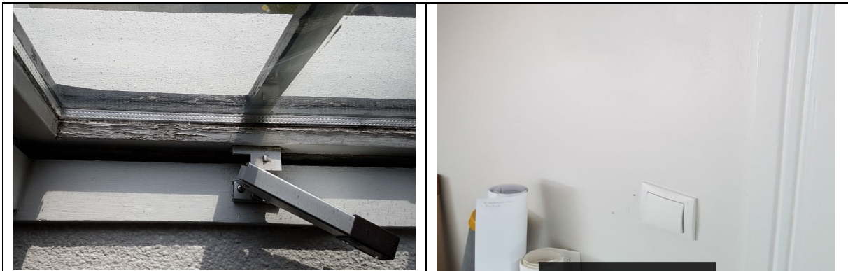
Myndir. Endurmála þarf glugga bæði innan- og utanhúss. Endurmála þarf hluta af veggjum innanhúss.
