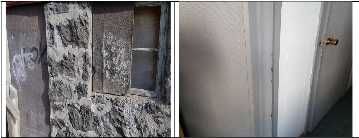
Myndir. Endurnýja þarf glugga og hurð í kjallara. Endurmála þarf veggi og annað tréverk innanhúss.
