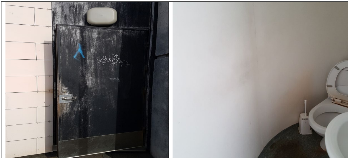
Myndir. Endurmála þarf útihurð og vegg innanhúss.
