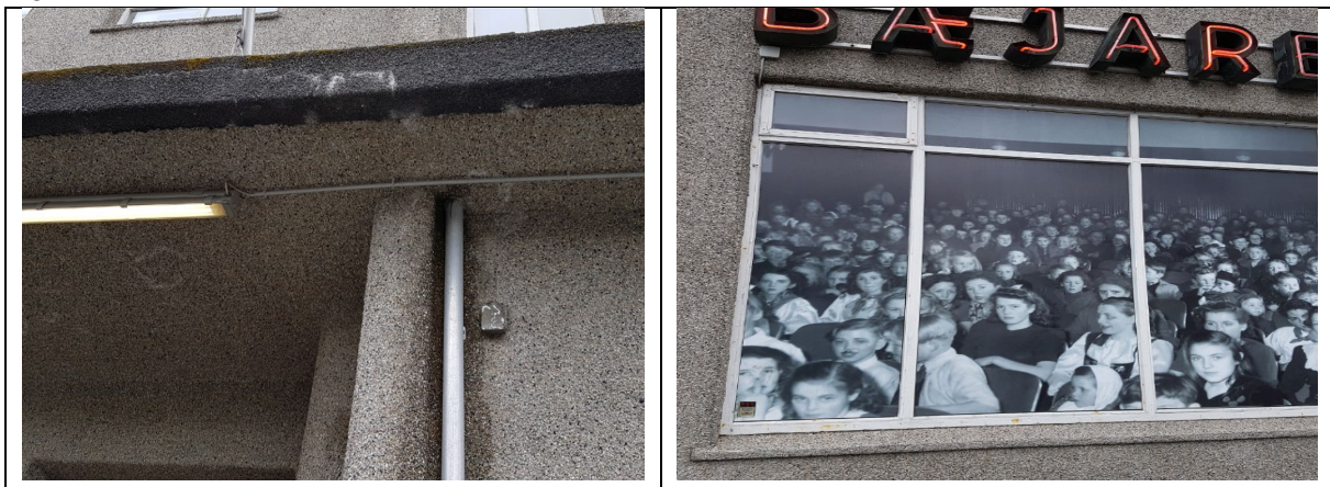
Myndir. Sílanbera þarf steiningu hússins til að hindra sprungumyndun. Endurmála þarf glugga utanhúss.
