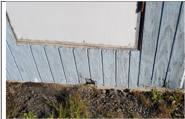
Mynd. Endurnýja þarf timburklæðningu utanhúss. Endurnýja þarf þakjárn, rennur, niðurföll og þakkant á geymslu.
