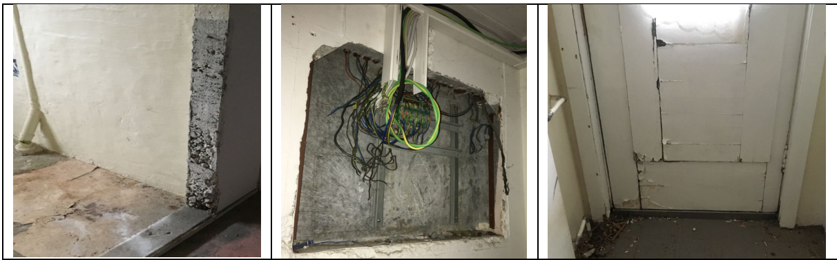
Myndir. Endurnýja þarf úti- og innihurðir. Einnig þarf að endurnýja raflagnir.
