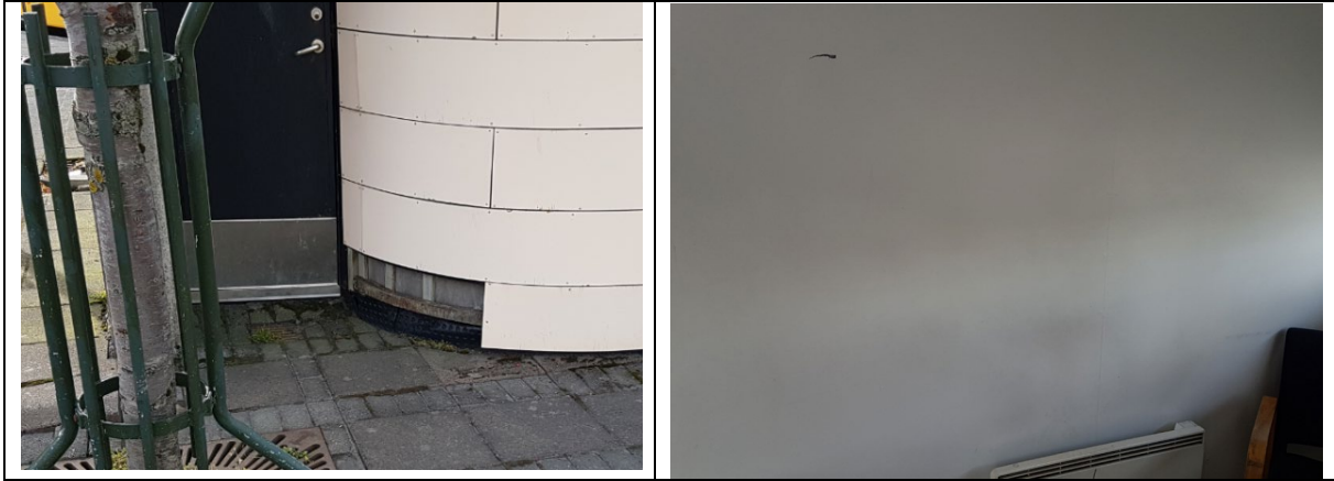
Myndir. Þarf að lagfæra klæðningu. Endurmála þarf vegg innanhúss.
