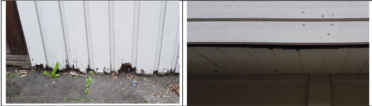
Mynd. Endurnýja þarf veggklæðningu og þakkant að hluta vegna fúa.
