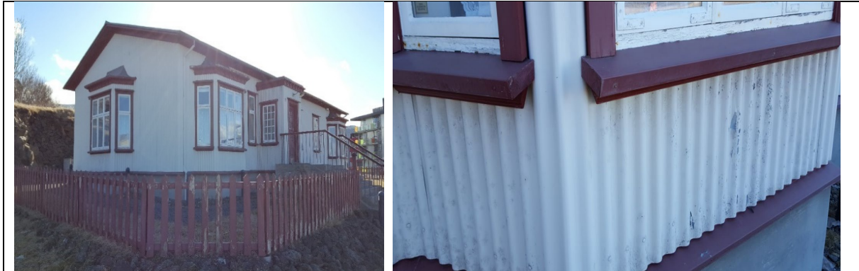
Mynd. Endurmála þarf bárujárnsklæðningu.
