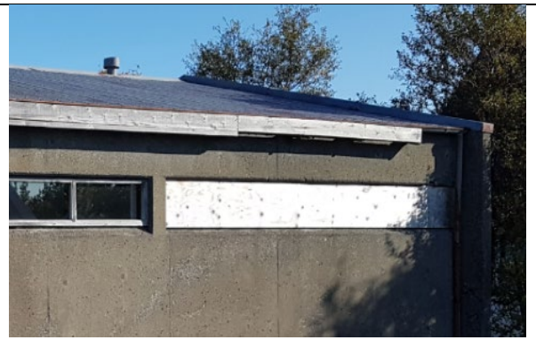
Mynd. Endurnýja þarf timburklæðningu utanhúss. Endurnýja þarf þakjárn, rennur, niðurföll og þakkant á geymslu.
