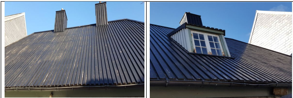
Myndir. Endurmála þarf þak og endurnýja nokkur timburborðum. Einnig þarf að endurnýja rennur og koma fyrir sterkari rennuböndum.
