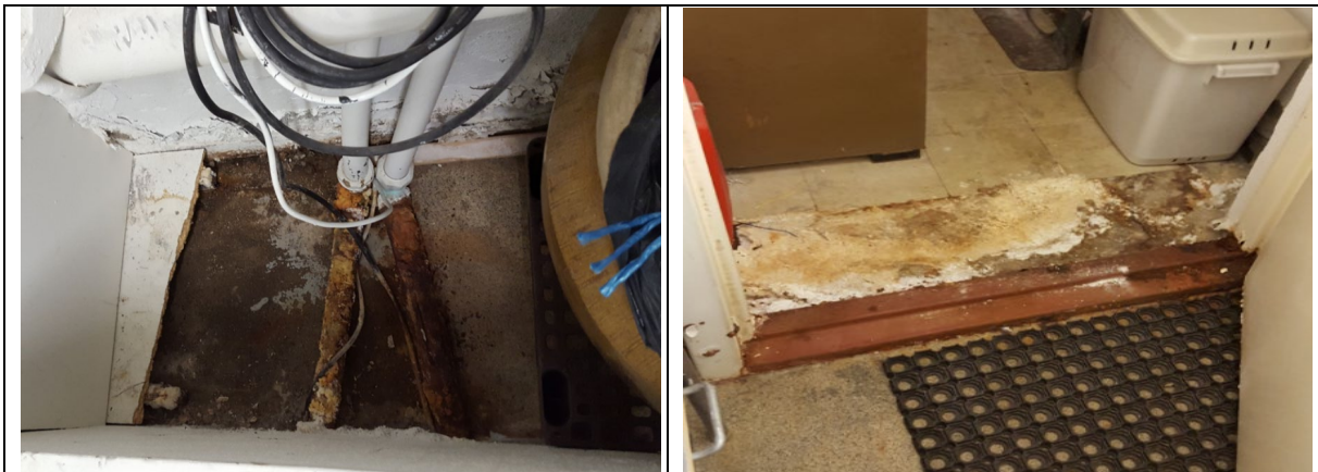
Mynd. Í kjallara þarf að skoða ástand lagna. Gólfefni í kjallara þarf að endurnýja.
