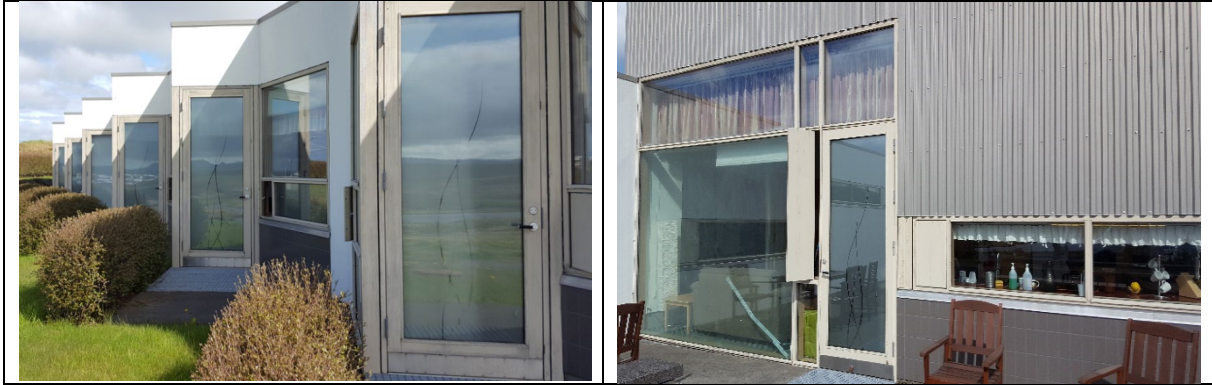
Mynd. Endurmála þarf allt tréverk utanhúss.
