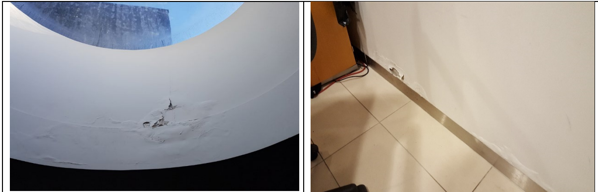
Mynd. Laga þarf rakaskemmdir víða um hús eftir leka.
