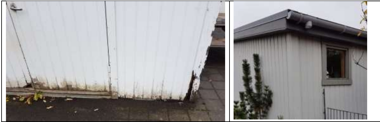
Mynd. Laga klæðningu og rennu á útihúsi
