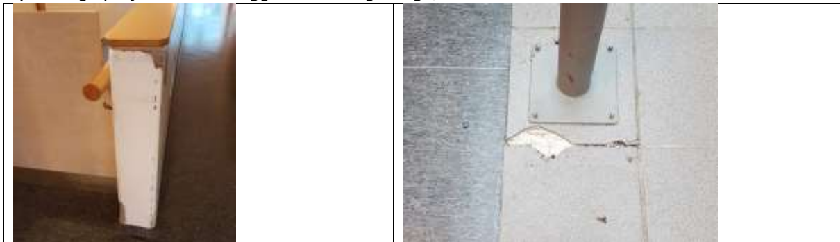
Mynd. Ýmsar smáviðgerðir innandyrna s.s. brotið upp úr veggjum, laga gólfefni
