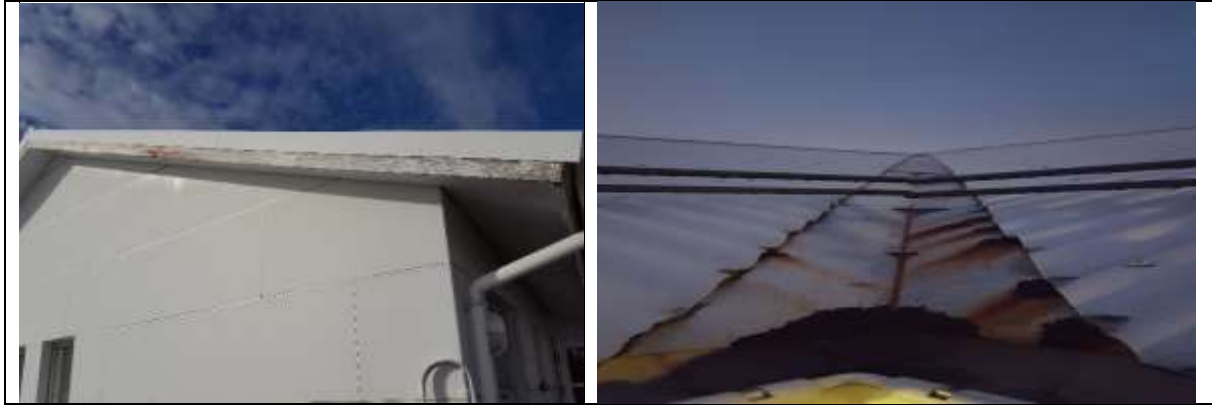
Mynd. Nær öll málning var farin af þakkanti, einnig var kominn fúi í timbrið á nokkrum stöðum. Í skotrennu er komið mikið ryð.
