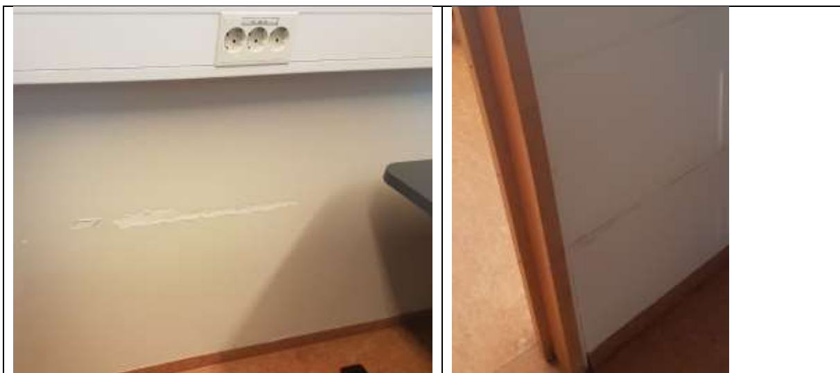
Mynd. Víða kominn tími á málun innandyra. Setja dúk á hluta veggja í gangi.
