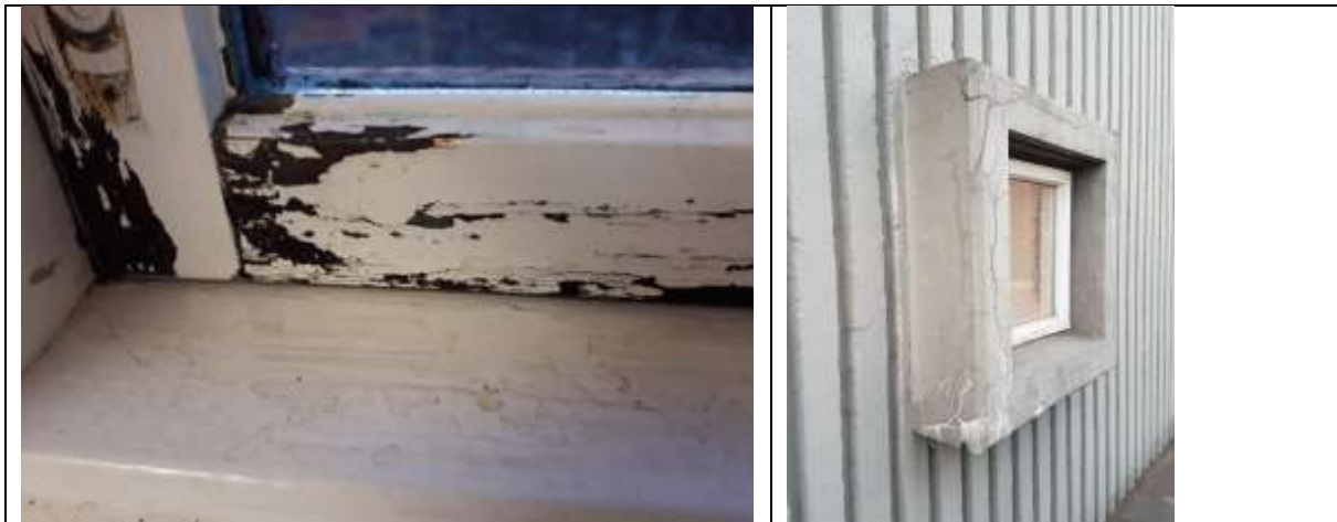
Mynd. Skipta um/laga glugga á vesturhlið. Löngu kominn tími á sprunguviðgerðir og málun á húsi
