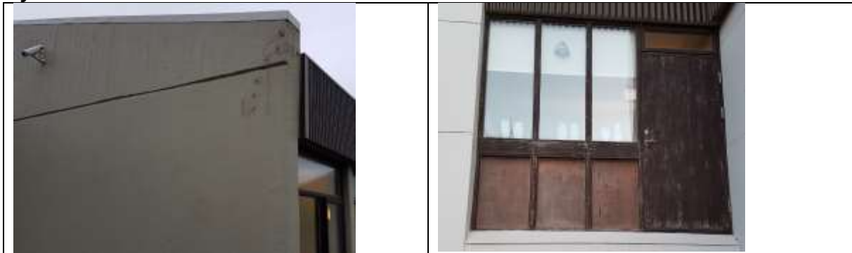
Mynd. Mála útvegg eftir sprunguviðgerðir. Bera á timburverk.
