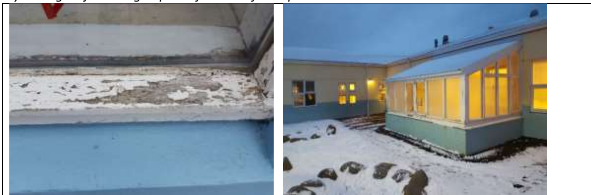
Mynd. Ástand timburglugga var ekki gott og hefði þurft að endurmála fyrir nokkrum árum. Endurmála þarf hluta húss að utan og setja rennu á viðbyggingu.
