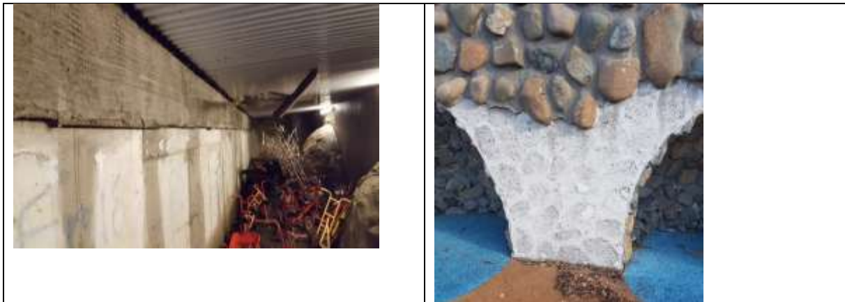
Mynd. Geymsla undir palli austanmegin er lek. Steinklæðning á geymslunni er hrúin af að hluta.
