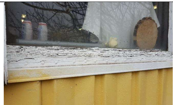
Mynd. Endurnýja þarf klæðningu og glugga hússins að hluta vegna fúa.
