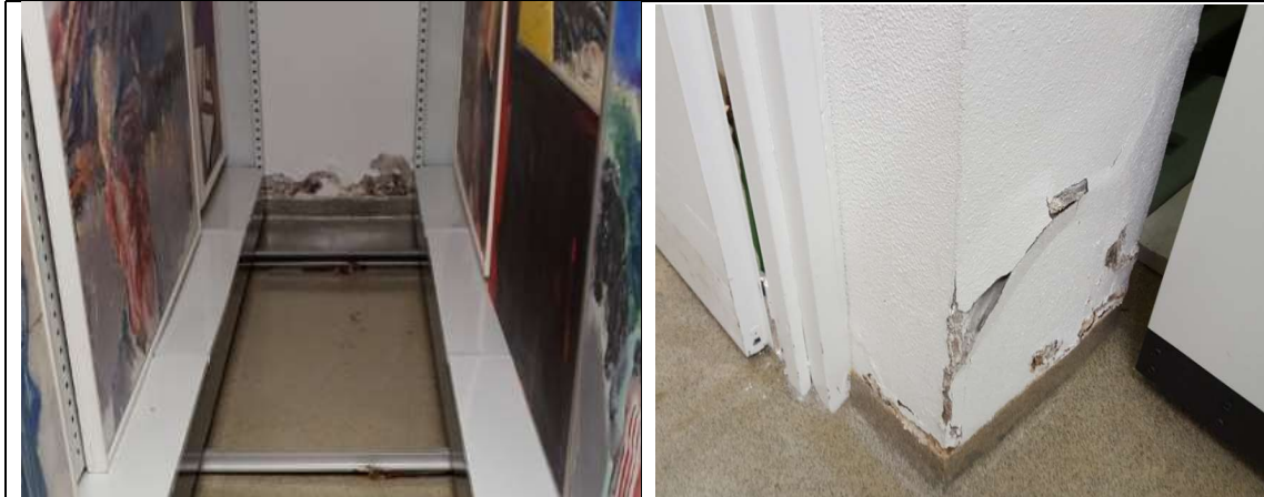
Mynd. Laga eftir leka, rekkar og listaverk farin upp á Hringhellu.
