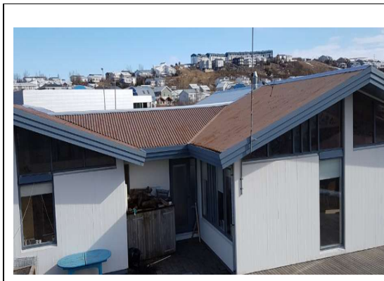
Mynd.. Endurnýja þarf þakjárn.
