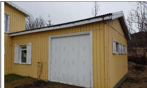
Mynd. Endurnýja þarf klæðningu og glugga hússins að hluta vegna fúa.
