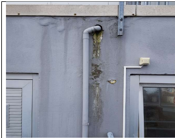
Myndir. Fara þarf í múr- og sprunguviðgerðir á útveggjum.
