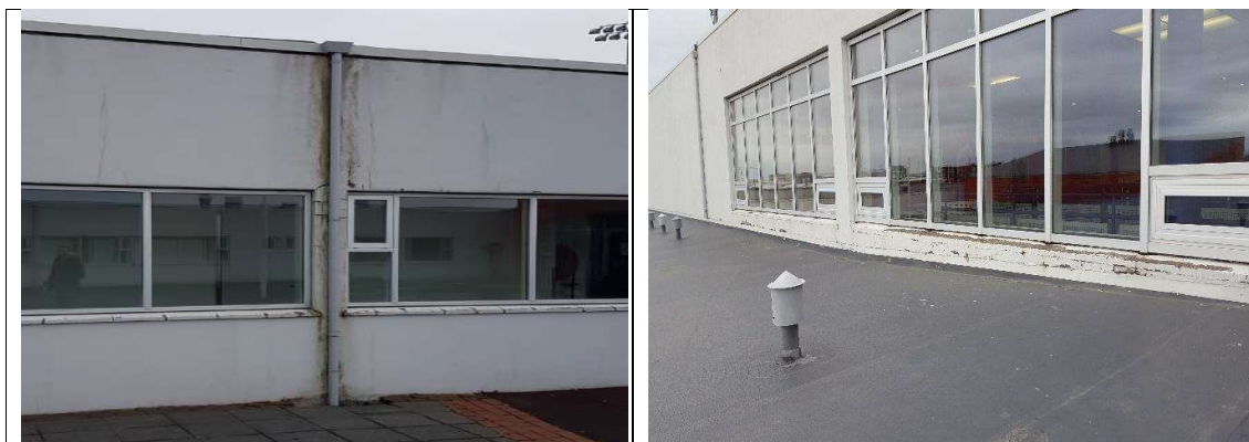
Mynd. Setja þarf rennu hringinn og ný niðurföll. Sílanbera vallarhús og mála glugga þar.
