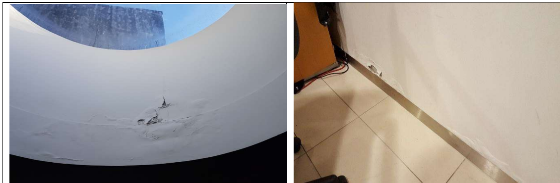
Mynd. Laga þarf rakaskemmdir víða um hús eftir leka.
