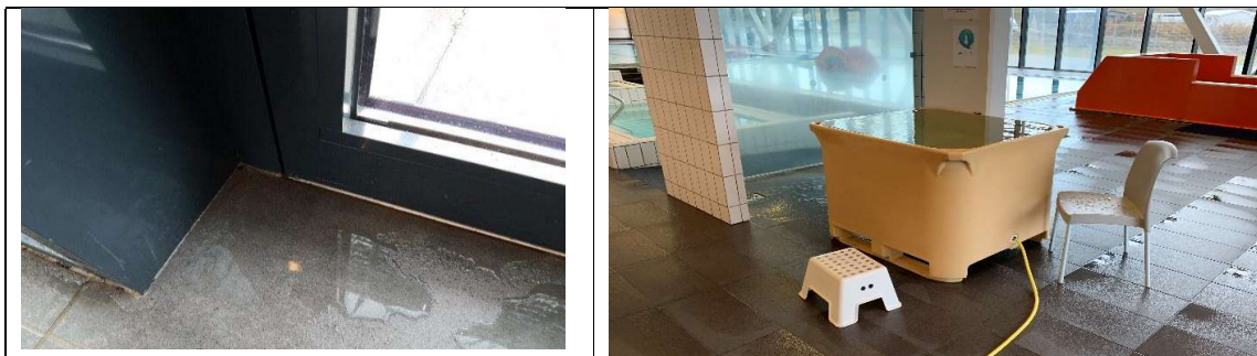
Mynd. Leki með gluggum og hurðum víða um bygginguna. Vantar kaldan pott alvöru ekki fiskikar
