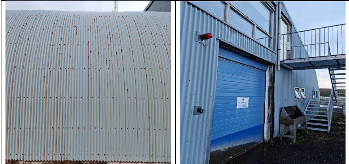
Myndir. Endurnýja þarf utanhússklæðningu á reiðsal. Þarf að ganga frá áfellum við hurðir.
