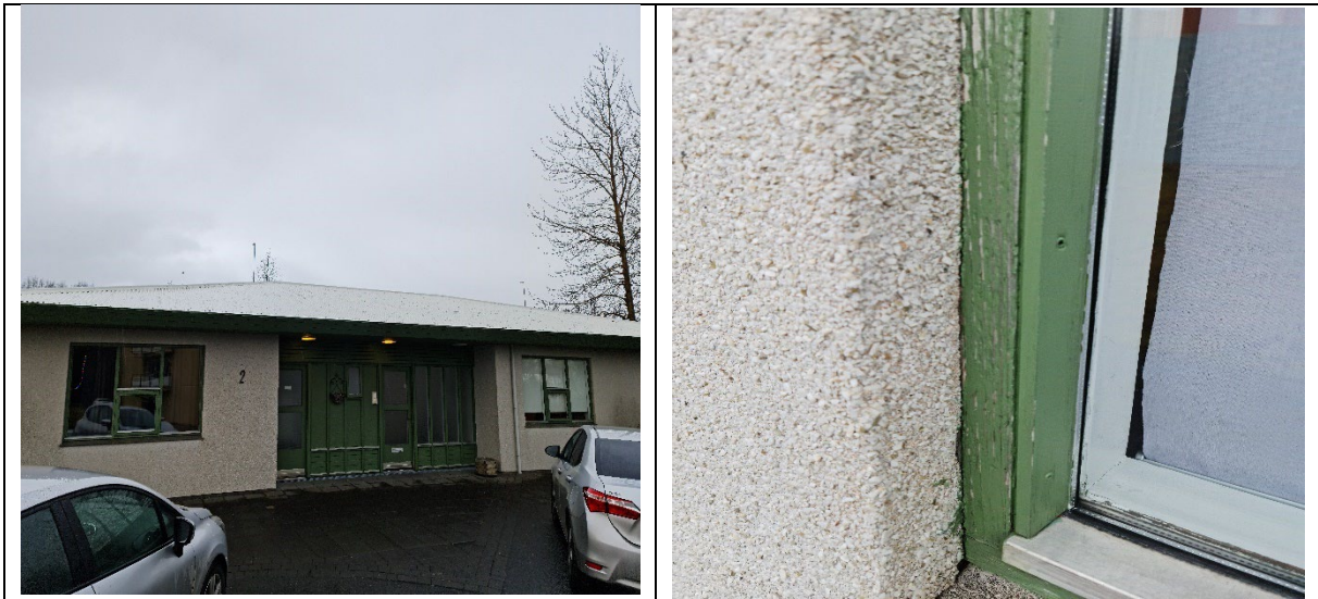
Myndir. Endurmála þarf þakjárn og tréverk utanhúss.
