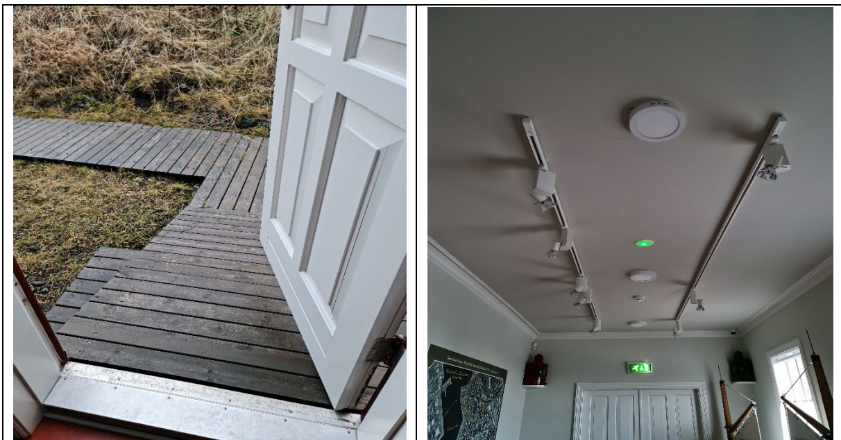
Mynd. Breyta þarf skábraut við útgang, er of brattur. Endurnýja þarf lýsingu.
