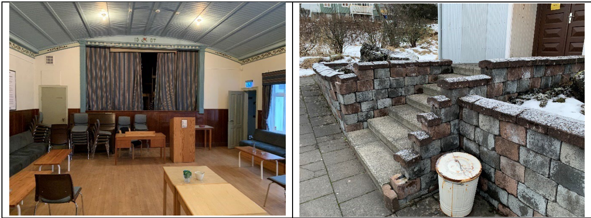
Myndir. Yfirfara þarf gólfefni. Þarf að endurhlaða lóðarveggi að hluta.
