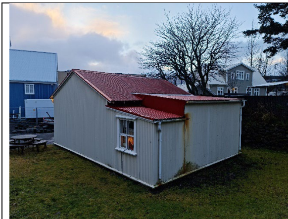
Myndir. Endurmála þarf útveggjaglæðningu. Lagfæra þarf frágang á þaki viðbyggingar vegna leka.
