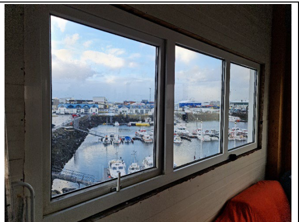
Myndir. Endurnýja móðugler. Lagfæra glugga í turni, ekki hægt að loka opnanlegu fagi.
