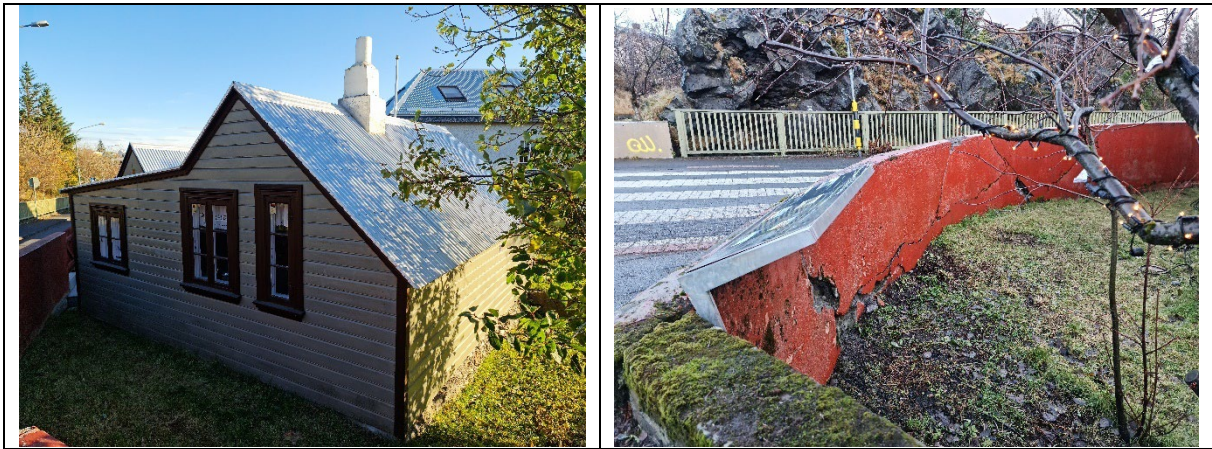
Myndir. Endurmála þarf skorstein. Endursteypa þarf stoðvegg að hluta og mála.
