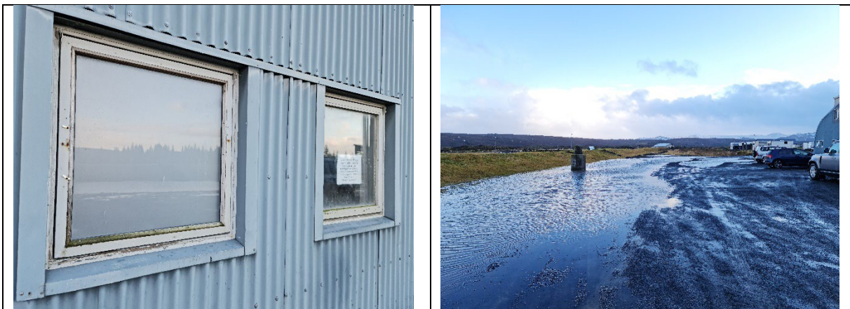
Myndir. Endurmála þarf glugga utanhúss. Malarefni vantar í plan framan við aðalbygginu, einnig þarf að finna lausnir á vatnssöfnun eftir rigningar.
