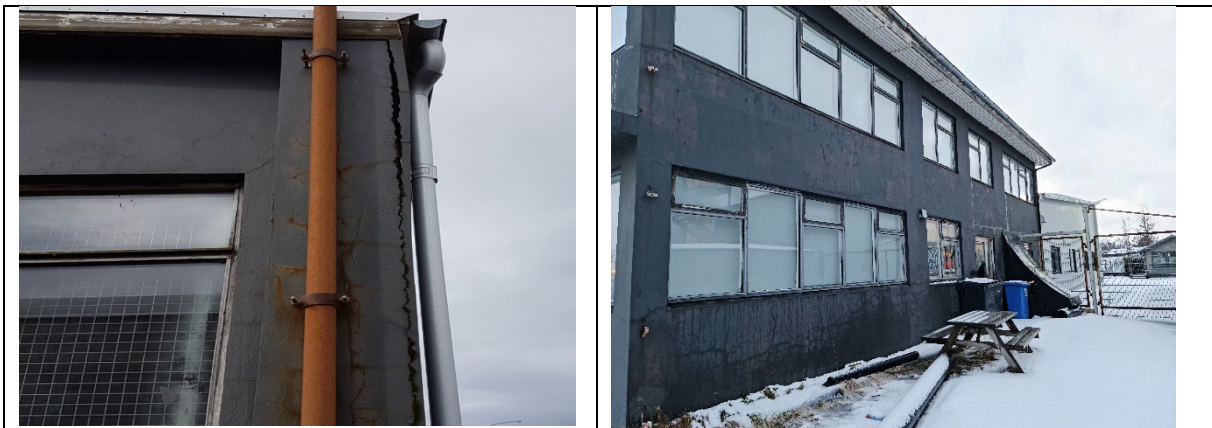
Myndir. Fara þarf í viðgerðir á steiptum flötum. Yfirfara þarf glugga vegna fúa, endurmála allt timburverk og endurnýja rennur og niðurföll.
