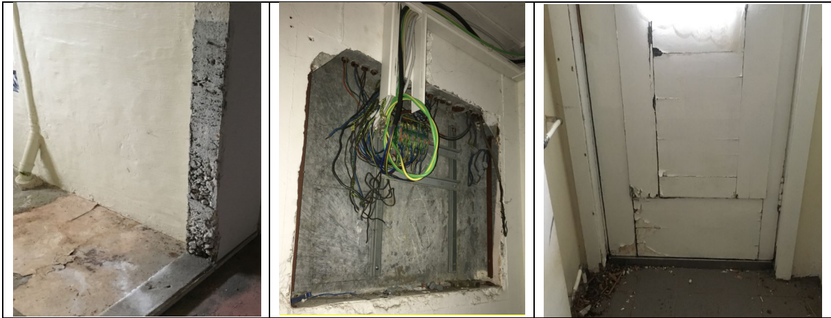
Myndir. Endurnýja þarf allar hurðir. Einnig þarf að endurnýja raflagnir.
