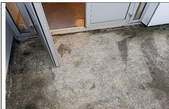
Myndir. Steypt gólf utanhúss er hærra en gólf 2. hæðar, rakaskemmdir innanhúss við neyðarhurð eru líklega vegna þessa.
