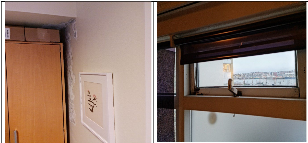
Myndir. Endurmála þarf vegg og glugga innanhúss og lagfæra eftir rakaskemmdir.
