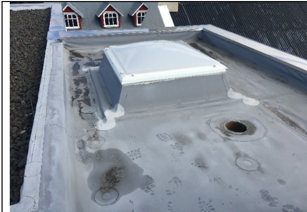
Myndir. Endurnýja þarf þakdúk á efsta þaki. Þetta með glugga vegna rakaskemmda á útvegg.
