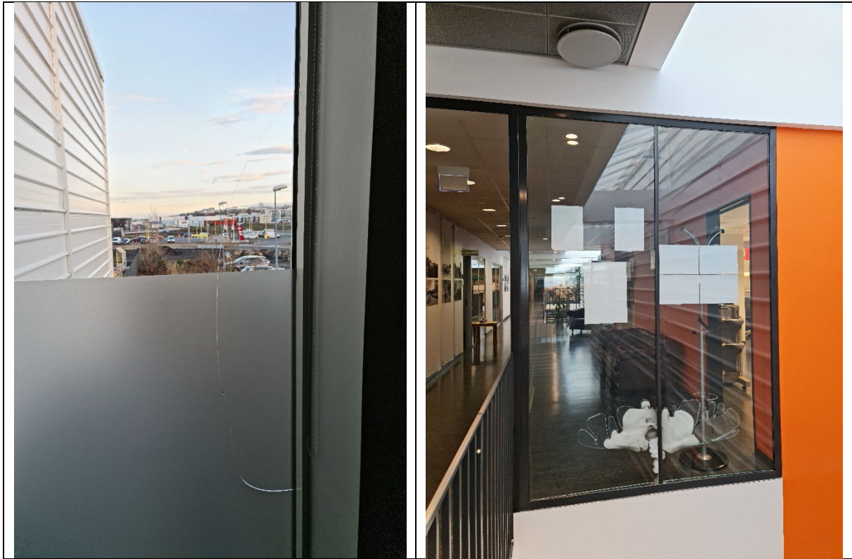
Mynd. Skipta þarf um öryggis- og eldvarnargler.
