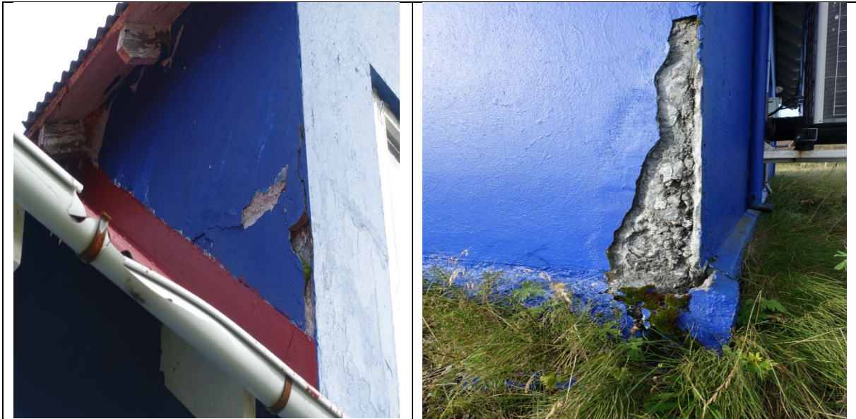
Mynd. Þarf að fara í umfangsmiklar viðgerðir á steyptum flötum.
