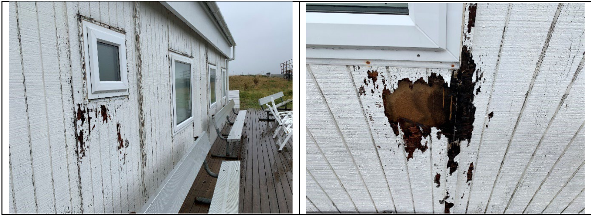
Myndir. Endurmála þarf klæðningu og endurnýja að hluta vegna fúa.
