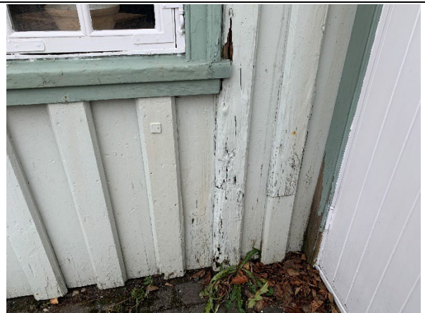
Myndir. Endurnýja þarf útveggjaklæðningu á norðurhlið vegna fúa.
