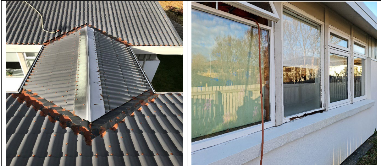
Myndir. Endurnýja þarf þakklæðningu. Endurnýja þarf glugga vegna fúa.
