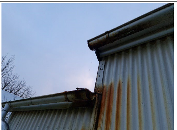
Myndir. Endurmála þarf útveggjaglæðningu. Lagfæra þarf frágang á þaki viðbyggingar vegna leka.
