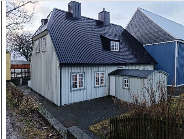
Myndir. Endurnýja þarf útveggjaklæðningu á norðurhlið vegna fúa.
