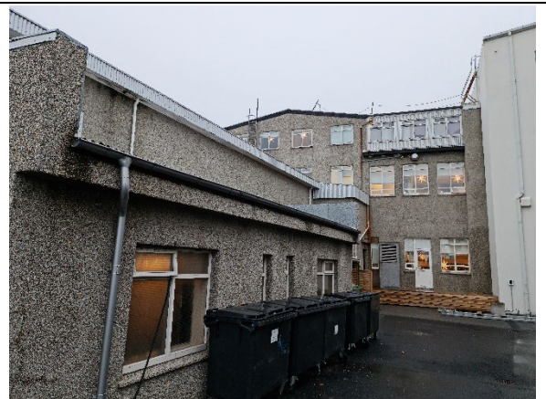
Myndir. Endurnýja þarf þakklæðningu. Yfirfara þarf glugga á bakhlið vegna leka inn í bygginguna. Einnig þarf að yfirfara rennu á útbyggingu, lekur niður um þakkant.
