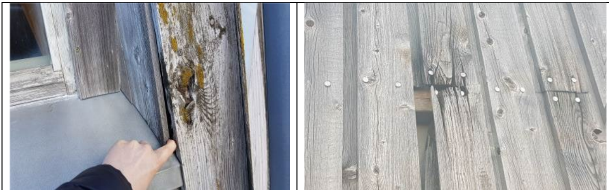
Myndir. Bera þarf á glugga og laga útveggjaglæðningu.
