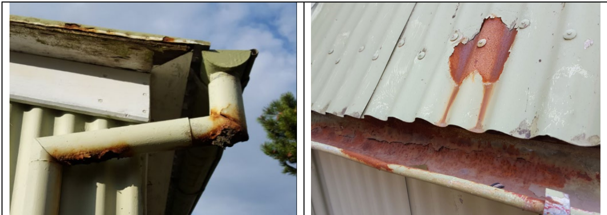
Myndir. Endurnýja þakjárn, þakkant, rennur og niðurföll.
