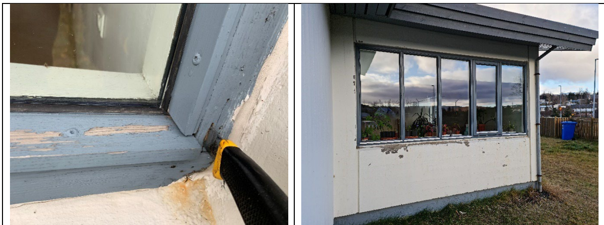
Myndir. Endurnýja þarf glugga að hluta vegna fúa. Fara þarf í múrviðgerðir og endurmála útveggi.
