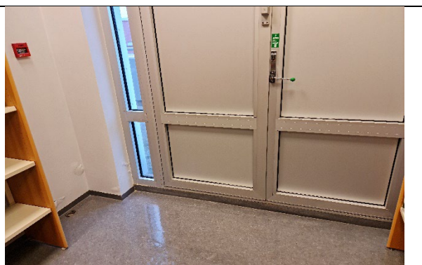
Myndir. Steypt gólf utanhúss er hærra en gólf 2. hæðar, rakaskemmdir innanhúss við neyðarhurð eru líklega vegna þessa.
