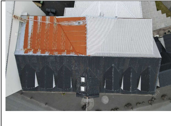
Myndir. Endurnýja þarf þakklæðningu. Yfirfara þarf glugga á bakhlið vegna leka inn í bygginguna. Einnig þarf að yfirfara rennu á útbyggingu, lekur niður um þakkant.
