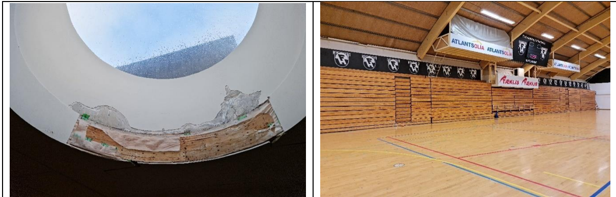
Myndir. Laga þarf vegna rakaskemmda. Slípa og lakka þarf parket og endurnýja áhorfendabekki.
