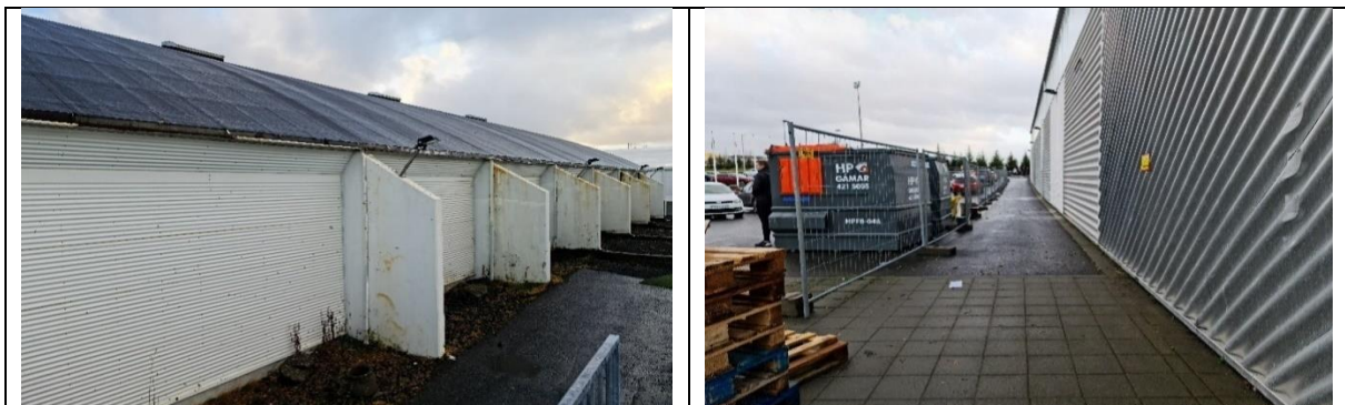
Myndir. Á parketsal þarf að endurnýja rennur og niðurföll, gera við steypa fleti og endurmála. Koma þarf upp varanlegri girðingu við göngustíg meðfram frjálsíþróttahúsi.
