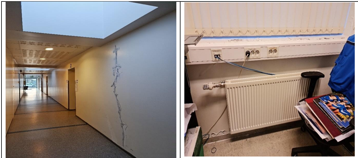
Myndir. Lekavandamál á tveimur stöðum sem þarf að koma í veg fyrir.
