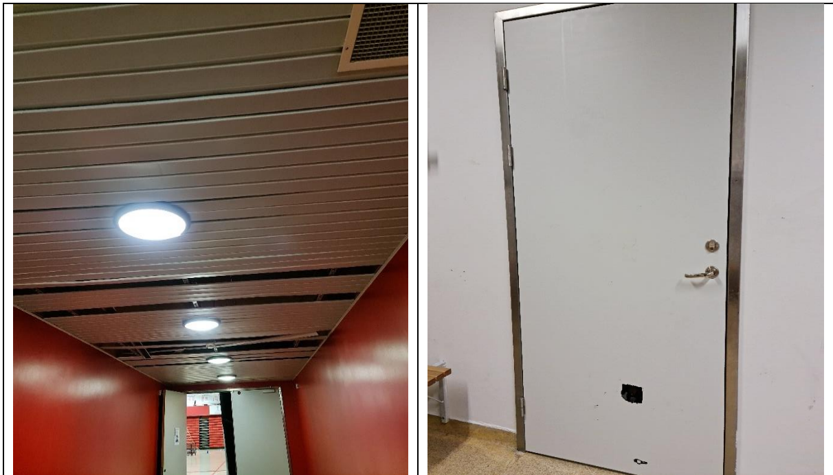
Myndir. Endurnýja þarf álstrimlaloft í búningsklefum og á göngum. Endurnýja þarf ónýtar hurðir í búningsklefum.
