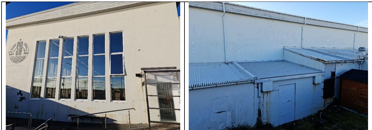
Myndir. Fara þarf í múr- og sprunguviðgerðir á norður- og austurhlið sem og endurmála fletina.
