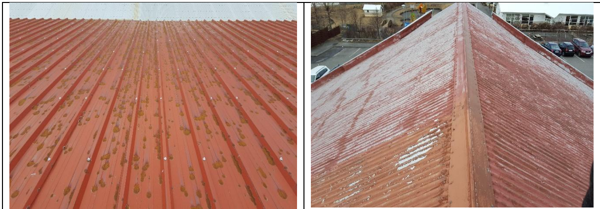
Myndir. Endurnýja þarf yleiningarþak yfir Andrasal. Endurnýja þarf bárujárnsþak yfir sal nr. 3.
