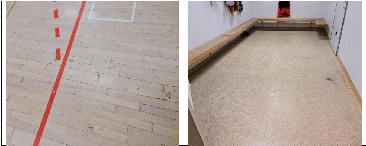
Myndir. Pússa og lakka parket í íþróttasal nr. 1. Í búningsklefum þarf að endurnýja gólfefni.
