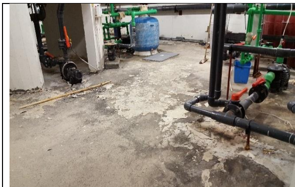
Myndir. Lakka þarf gólf í tæknirými. Endurnýja þarf gólfefni í tækjasal.
