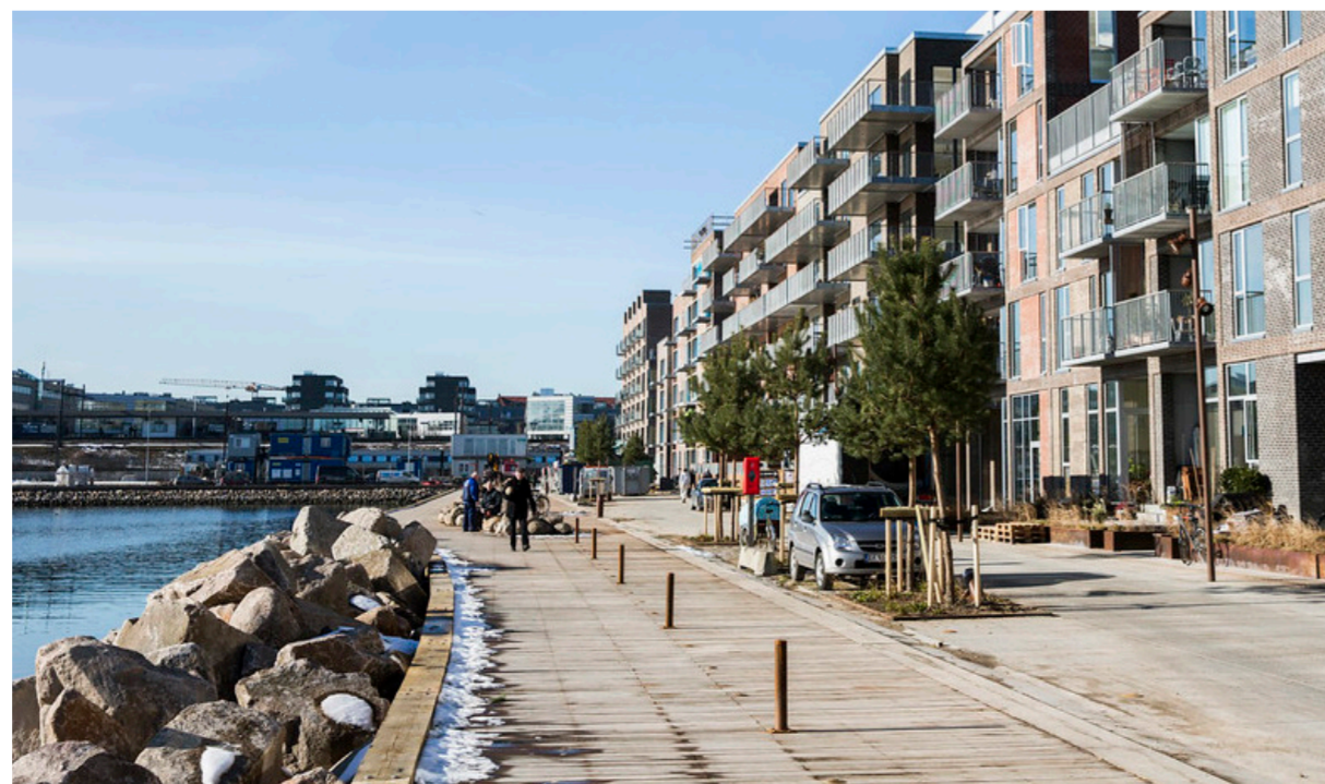
Dæmi um vistvæna hlið að sjónum þar sem notuð eru náttúruleg byggingarefni.
