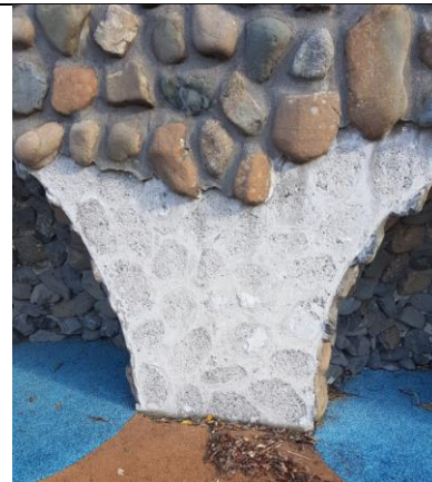
Mynd. Geymsla undir palli austanmegin er lek. Steinklæðning á geymslunni er hrunin af að hluta.
