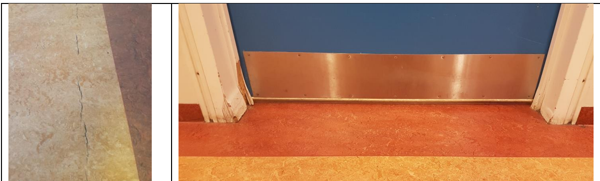
Mynd. Laga þarf gólfefni s.s. yfirfara suður og laga sprungur í dúkum. Hurðakarmar víða orðnir uppþógnir vegna raka frá ræstingu.
