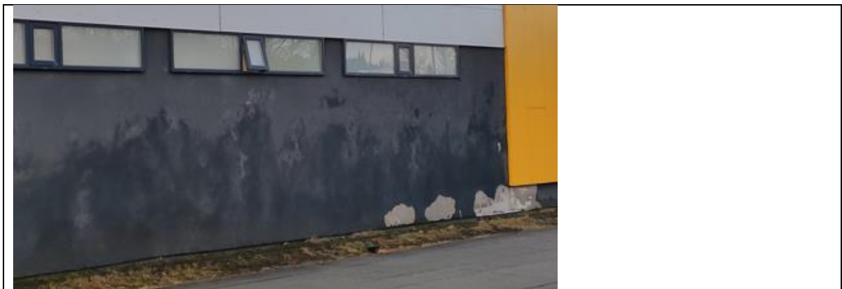
Mynd. Laga þarf ímúr kerfi, byrjað að brotna
