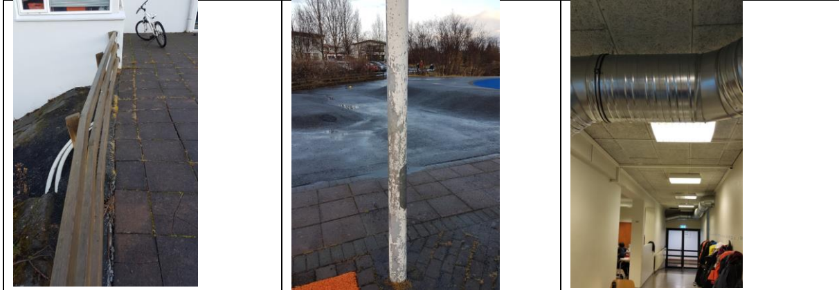
Mynd. Laga snjóbræðslu, hellulögn og mála ljósastaura klára frágang við loftræstingu
