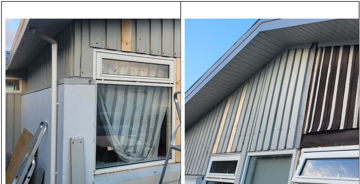
Myndir. Endurnýja þarf þakklæðningu. Endurnýja þarf glugga vegna fúa.
