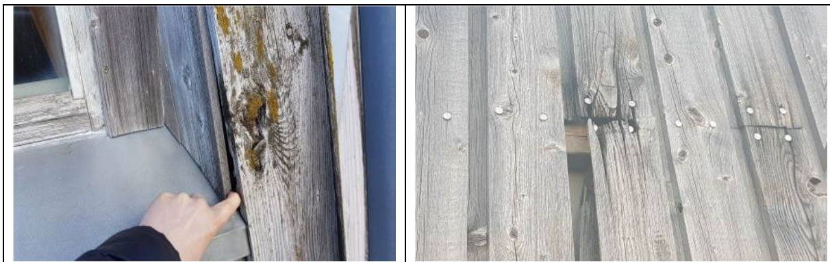
Myndir. Bera þarf á glugga og laga útveggjaklæðningu.
