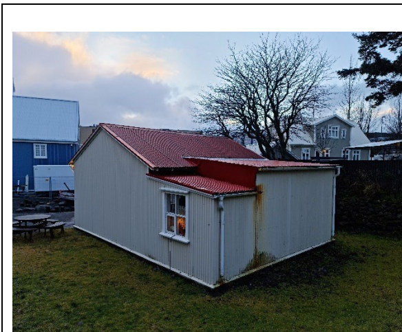
Myndir. Endurmála þarf útveggjaglæðningu. Lagfæra þarf frágang á þaki viðbyggingar vegna leka.
