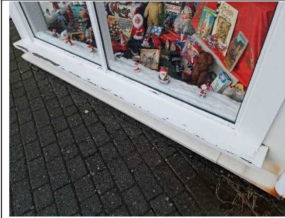
Myndir. Endurmála þarf glugga og annað timburverk.
