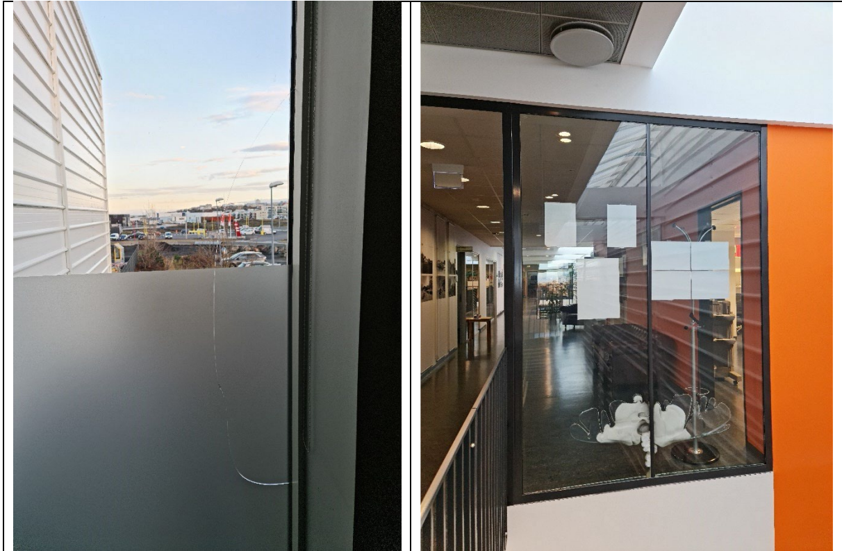
Mynd. Skipta þarf um öryggis- og eldvarnargler.
