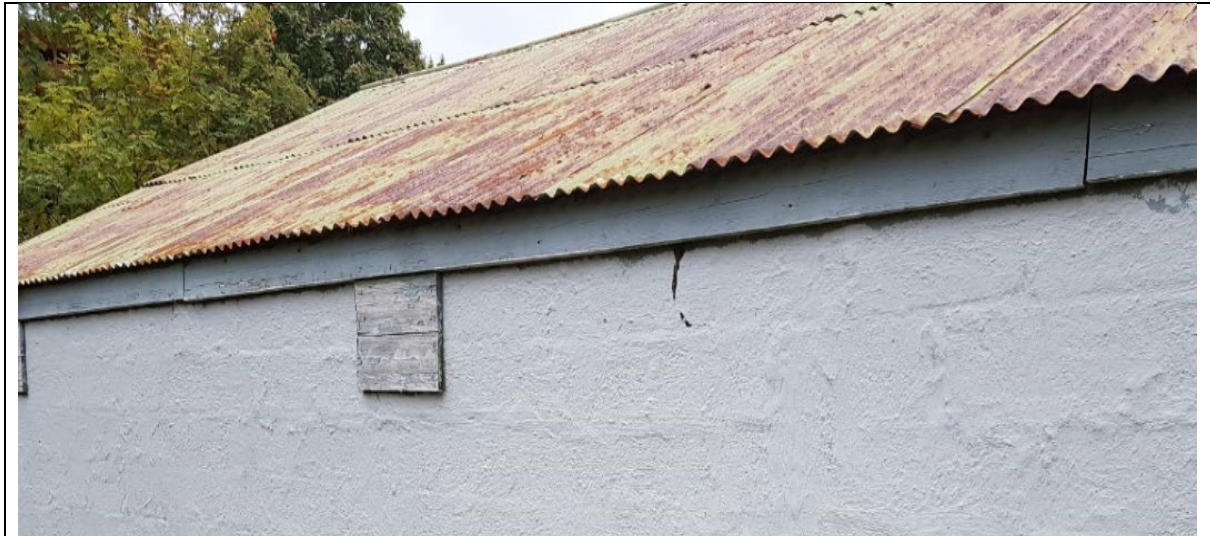
Myndir. Endurnýja þarf þakjárn..
