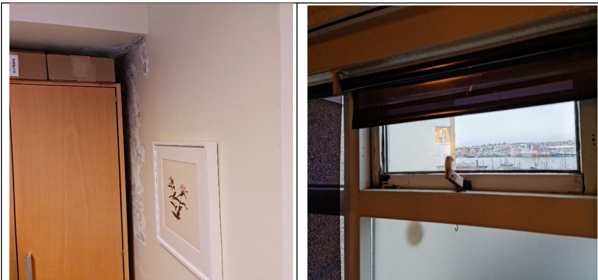
Myndir. Endurmála þarf veggi og glugga innanhúss og lagfæra eftir rakaskemmdir.
