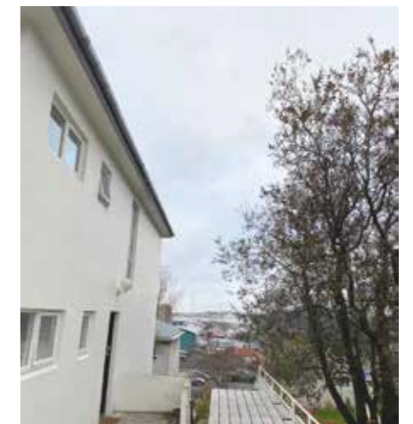
Horft á milli Suðurgötu 66 og 68
