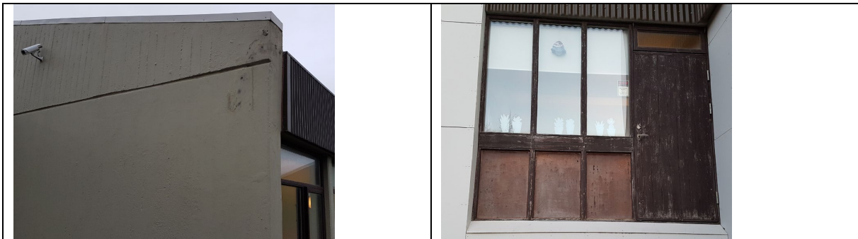
Mynd. Mála útvegg eftir sprunguviðgerðir. Skipta um útifront á skrifstofu.
