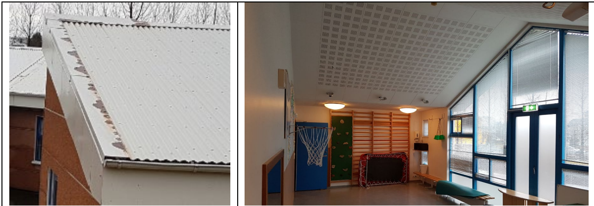
Mynd. Rið er komið í kjöl og flasningar á þaki. Laga þarf hljóðvist.
