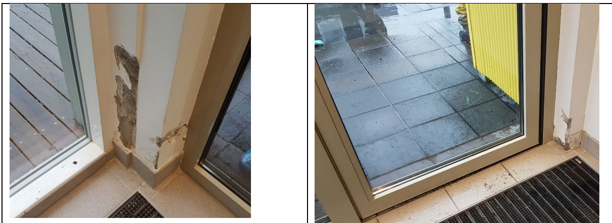
Mynd. Meta þarf hvernig til tókst að laga leka með gluggum og útihurðum.
