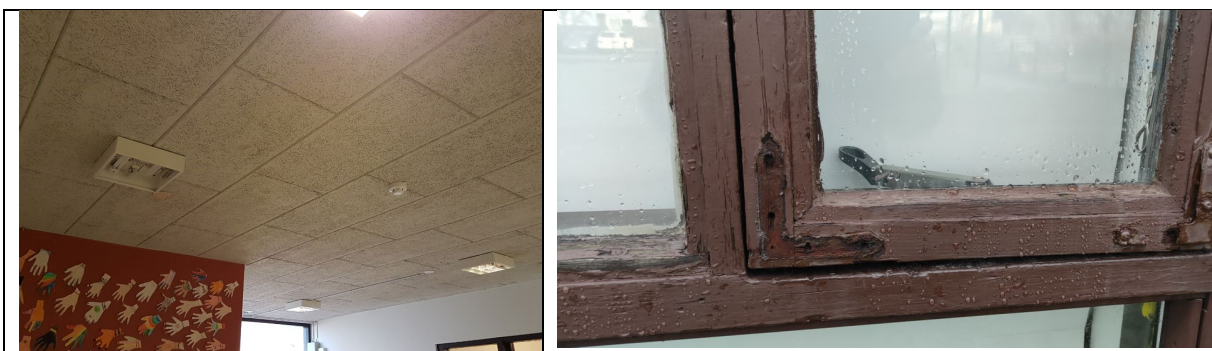
Mynd. Laga hljóðvist og skipta út gömlum ljósbúnaði. Skipta út 4 gömlum gluggum.
