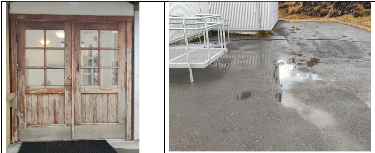
Mynd. Laga útidyrhurð. Mála fatlað stæði á lóð og setja upp skilti.
