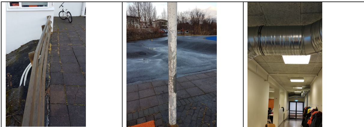
Mynd. Laga snjóbræðslu, hellulögn, mála ljósastra.
