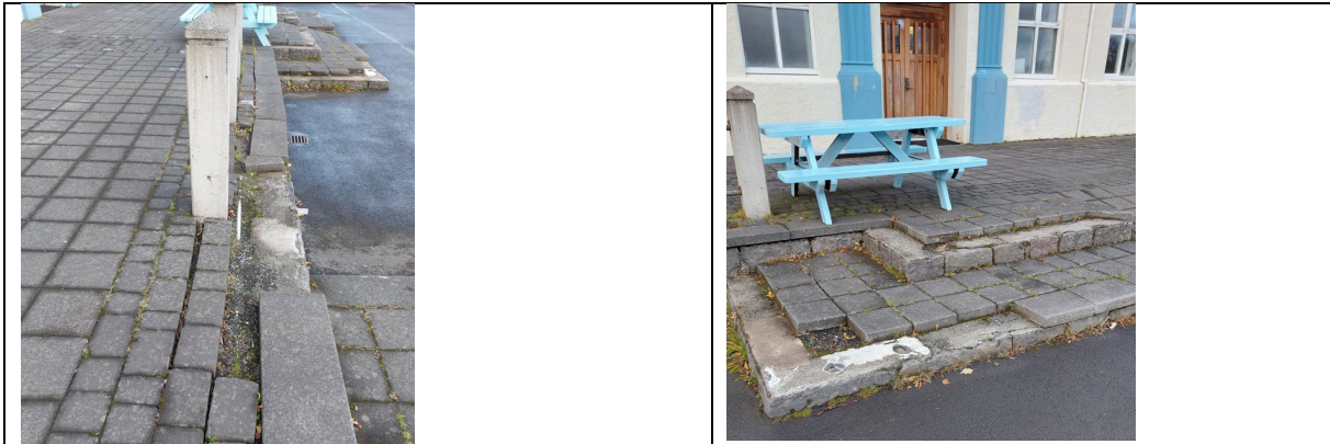
Mynd. Lagfæringar á hellulögn á lóð og pússa upp og laga útihurð og inngang inn í húsið.
