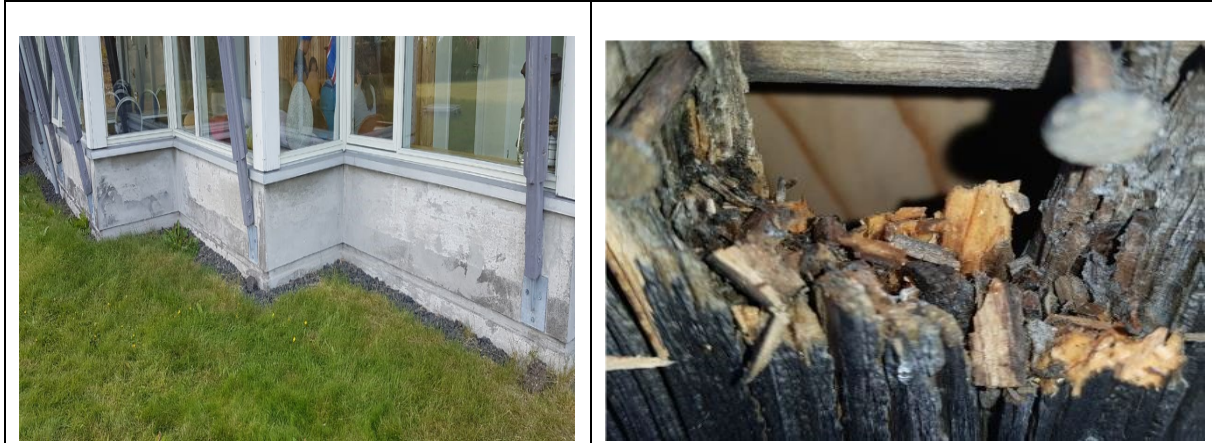
Myndir. Þarf að endurnýja útveggjaklæðningu.
