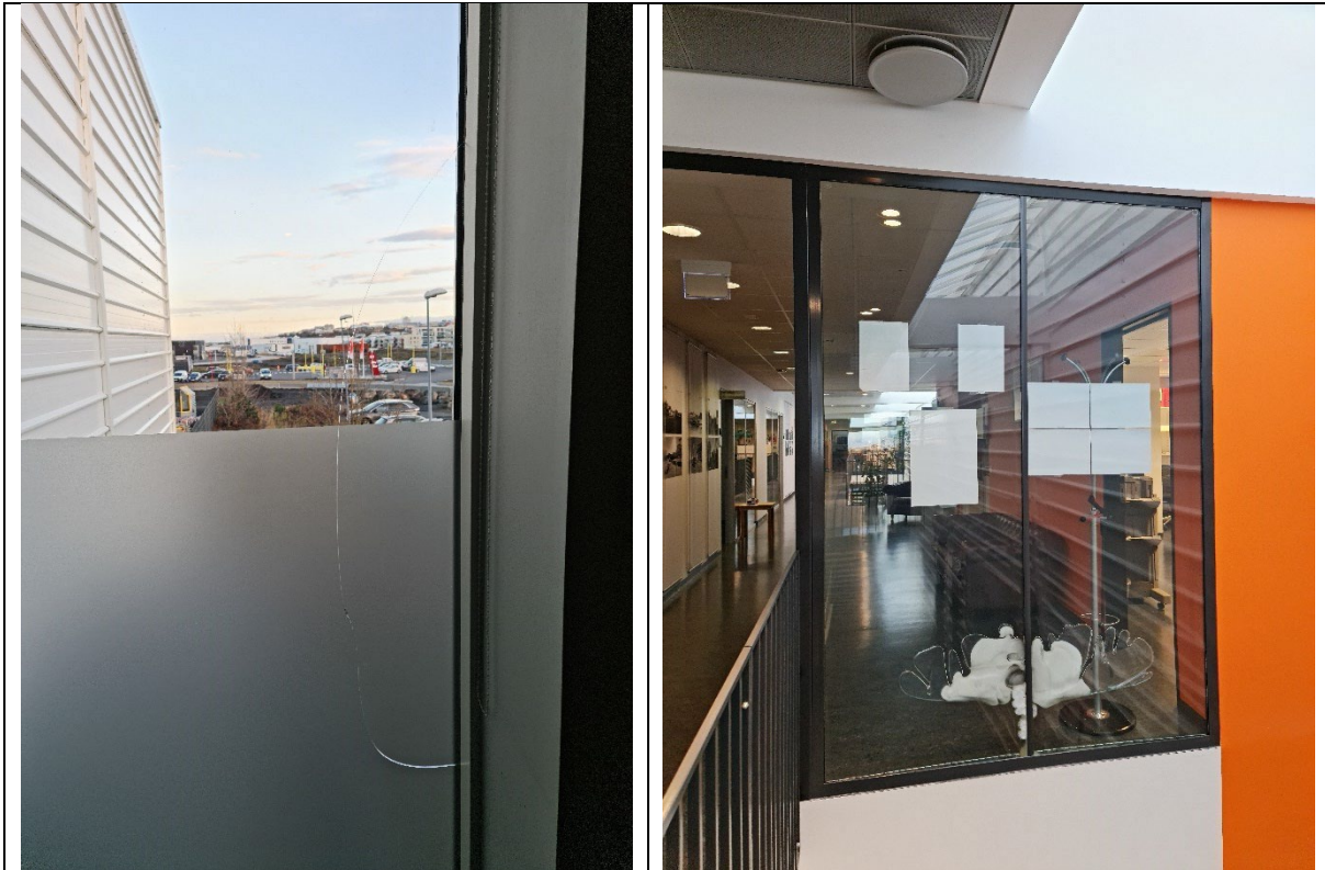
Mynd. Skipta þarf um öryggis- og eldvarnargler.
