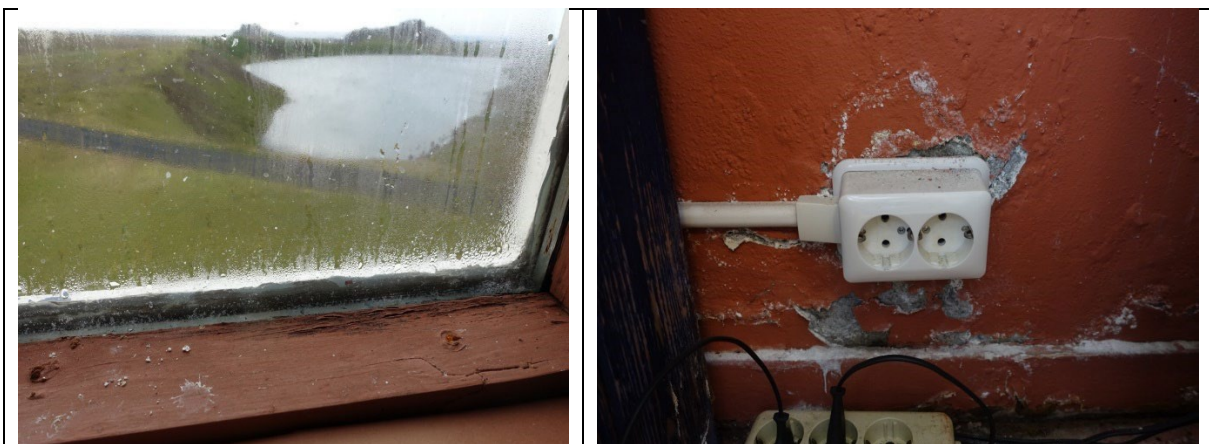
Mynd. Endurnýja þarf glugga og gera við steipta fleti vegna rakaskemmda.
