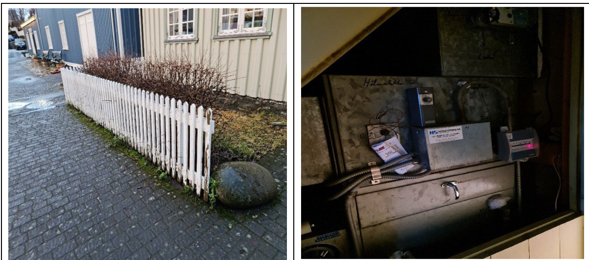
Myndir. Endurmála þarf grindverk framan við hús. Yfirfara þarf loftræsisamstæðu, virkar ekki sem skyldi.
