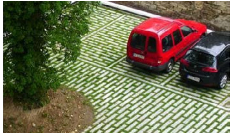
Dæmi um bílastæði með gegndræpu yfirborði
