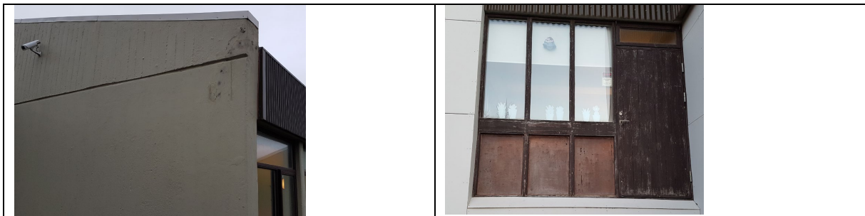
Mynd. Mála útvegg eftir sprunguviðgerðir. Skipta um útifront á skrifstofu.
