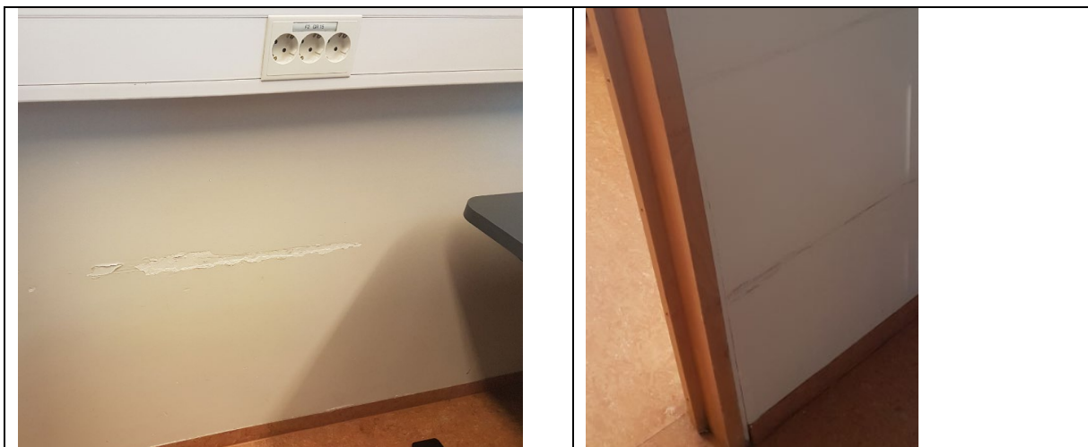
Mynd. Víða kominn tími á málun innandyra. Setja dúk á hluta veggja í gangi.
