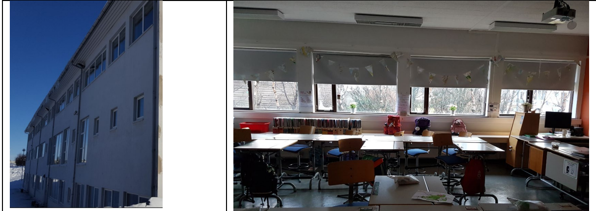
Mynd. Múrviðgerðir og málun á SA hlið skólans. Skipta þarf út nokkrum gluggum
