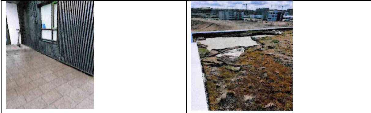
Mynd. Báruklæðning víða skemmd. Torf farið að losna af þaki A álmu
